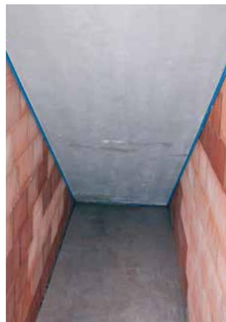
Abb. 14: Die blaue Linie zeigt den schallbrückenfreien Einbau als Qualitätsmerkmal für einen sicheren Trittschallschutz.
