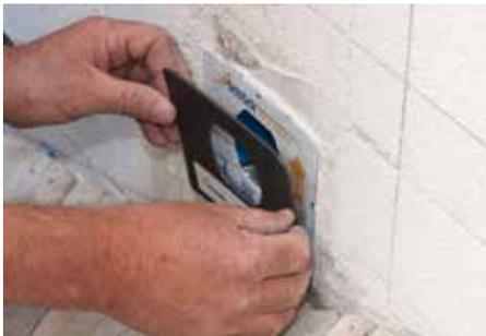
Abb. 6: Typ Q Wandelement einmauern. R 90 Brandschutzabdeckung aufbringen
