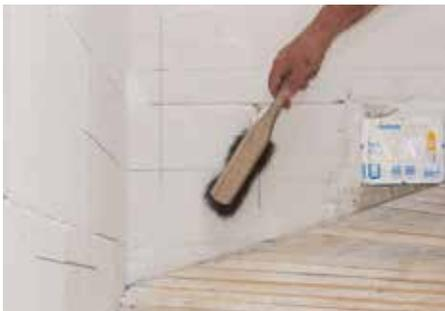
Abb. 3: Staub und Schmutz entfernen
