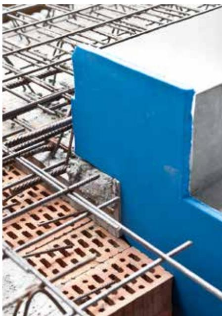
Abb. 12: Die Konsole ist mit der Typ F akustisch entkoppelt und die Fuge wird mit der Tronsole® Typ L schallbrückenfrei ausgeführt.
