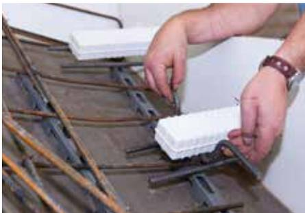
Abb. 3: Hutbügel einsetzen
