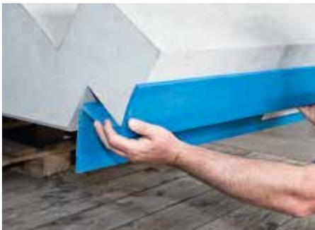
Abb. 3: Typ F ausrichten und aufkleben
