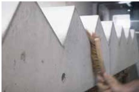
Abb. 3: Staub und Schmutz entfernen
