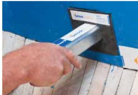
Abb. 7: R 90 Brandschutzmanschette einbauen. Typ Q Tragelement einschieben.
