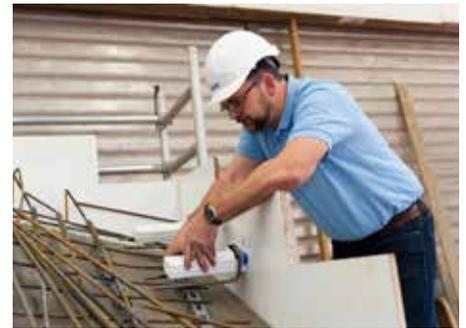
Abb. 2: Typ Q Laufhülse einbauen
