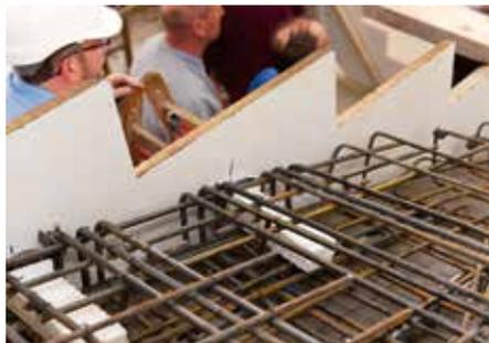
Abb. 4: Bewehrung verlegen und betonieren
