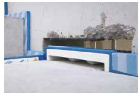
Abb. 11: Wandöffnungen mit Mörtel verfüllen
