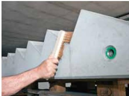
Abb. 1: Staub und Schmutz entfernen
