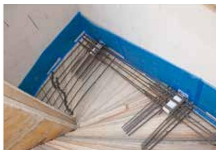
Abb. 10: Bewehrung verlegen und betonieren
