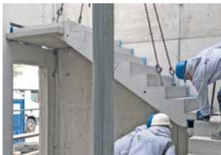
Abb. 10: Treppe einfahren und absetzen
