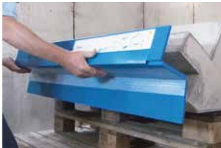
Abb. 4: Typ F ausrichten und aufkleben
