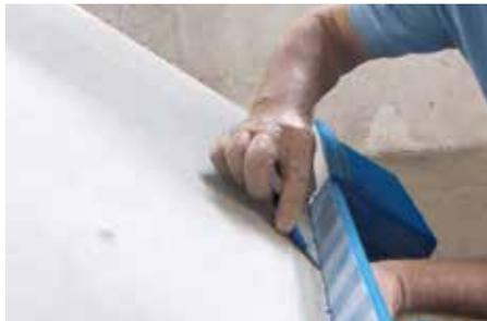
Abb. 6: Typ L Klebefolie einritzen
