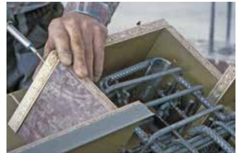
Abb. 2: Konsole fertig schalen, anschließend betonieren
