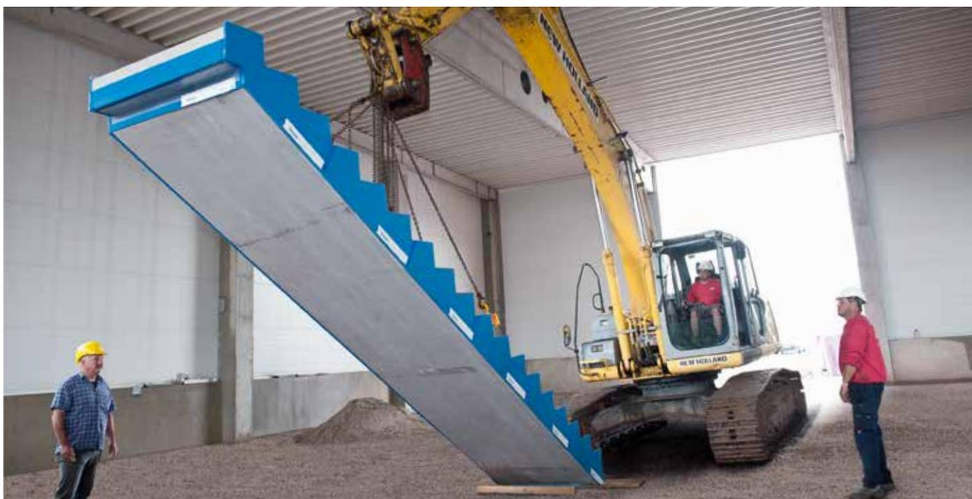
Abb. 11: Der mit Tronsole® umlaufend beklebte Fertigteiltreppenlauf kann direkt auf der Baustelle eingesetzt werden.
