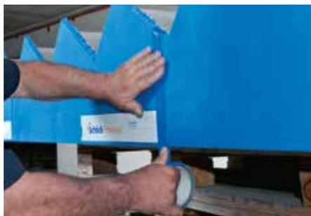
Abb. 10: Typ L Fugen mit Klebeband abdecken
