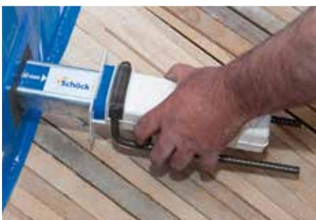
Abb. 9: Typ Q Laufhülse aufstecken
