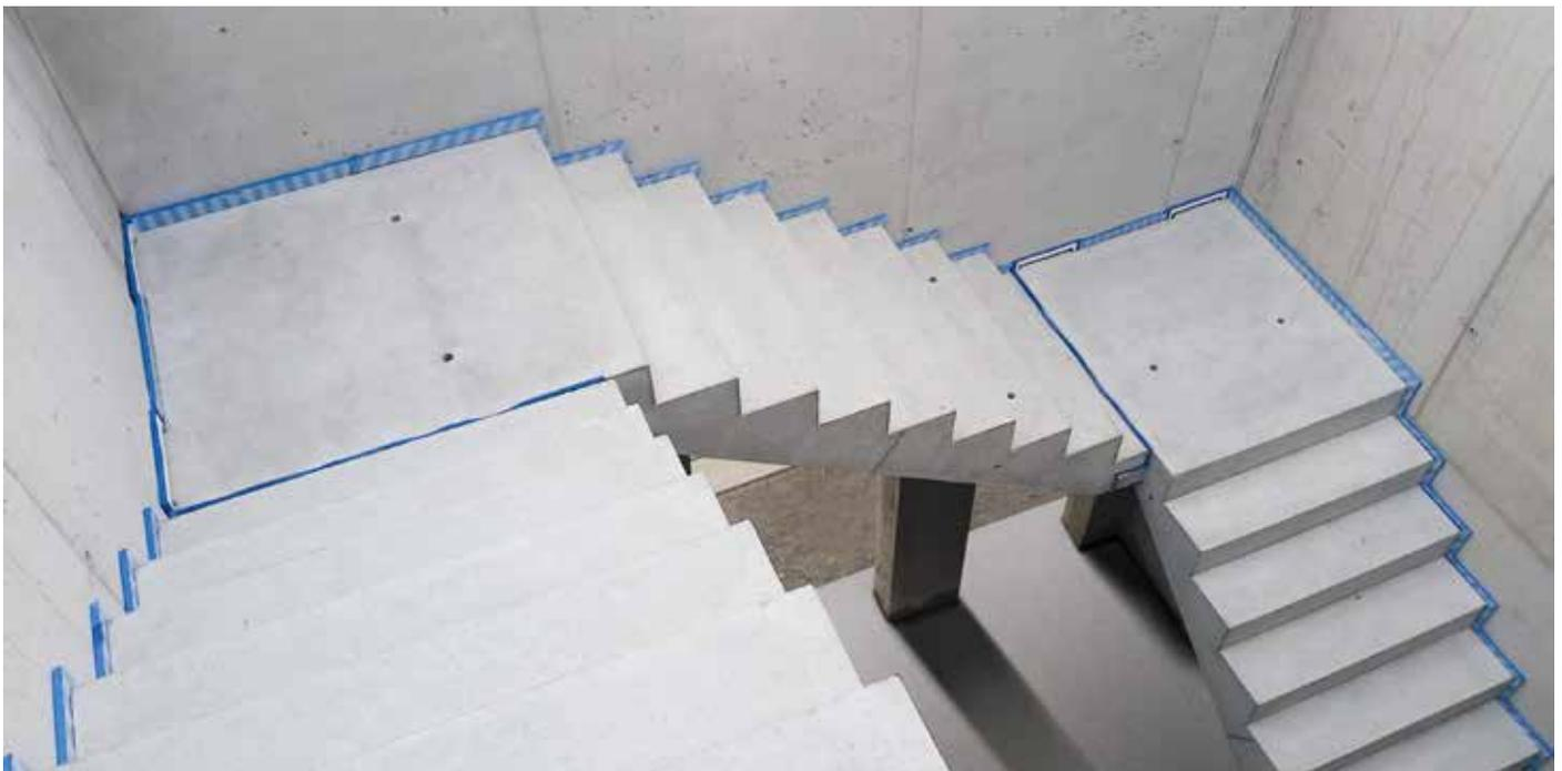
Abb. 15: Die blaue Linie zeigt den schallbrückenfreien Einbau als Qualitätsmerkmal für einen sicheren Trittschallschutz.
