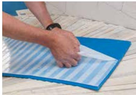
Abb. 4: Typ L Folie zur Hälfte entfernen
