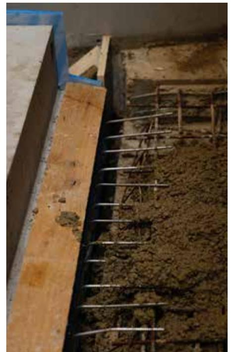
Abb. 13: Anschlussbereich Typ T betonieren
