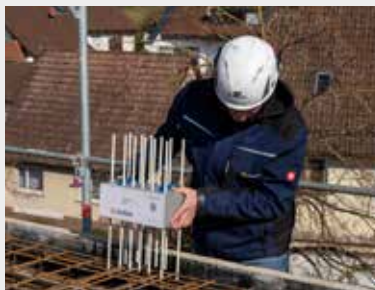
5. Einsetzen von Isokorb® CXT Typ A.
