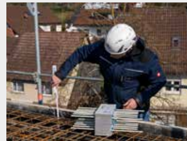
2. Kontrolle der Einbindelänge.
