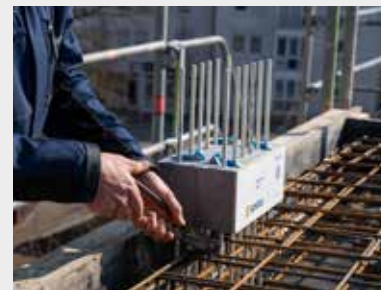
6. Anbinden der Combar® Stäbe an der Deckenbewehrung für einen sicheren Stand während des Betonvorgangs.
