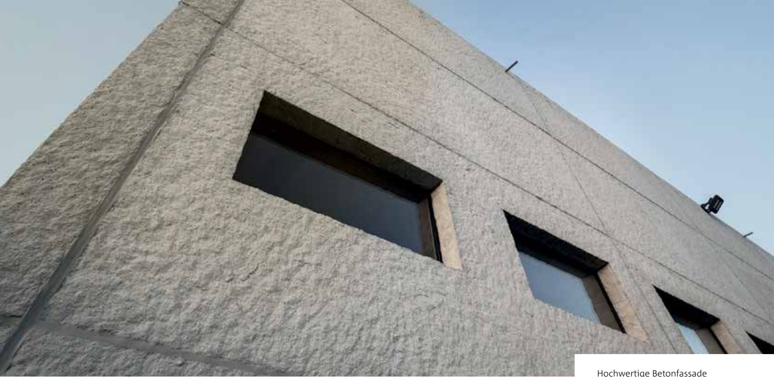
Hochwertige Betonfassade in Natursteinoptik der Industriehalle der Marcus Riedelsheimer GmbH
