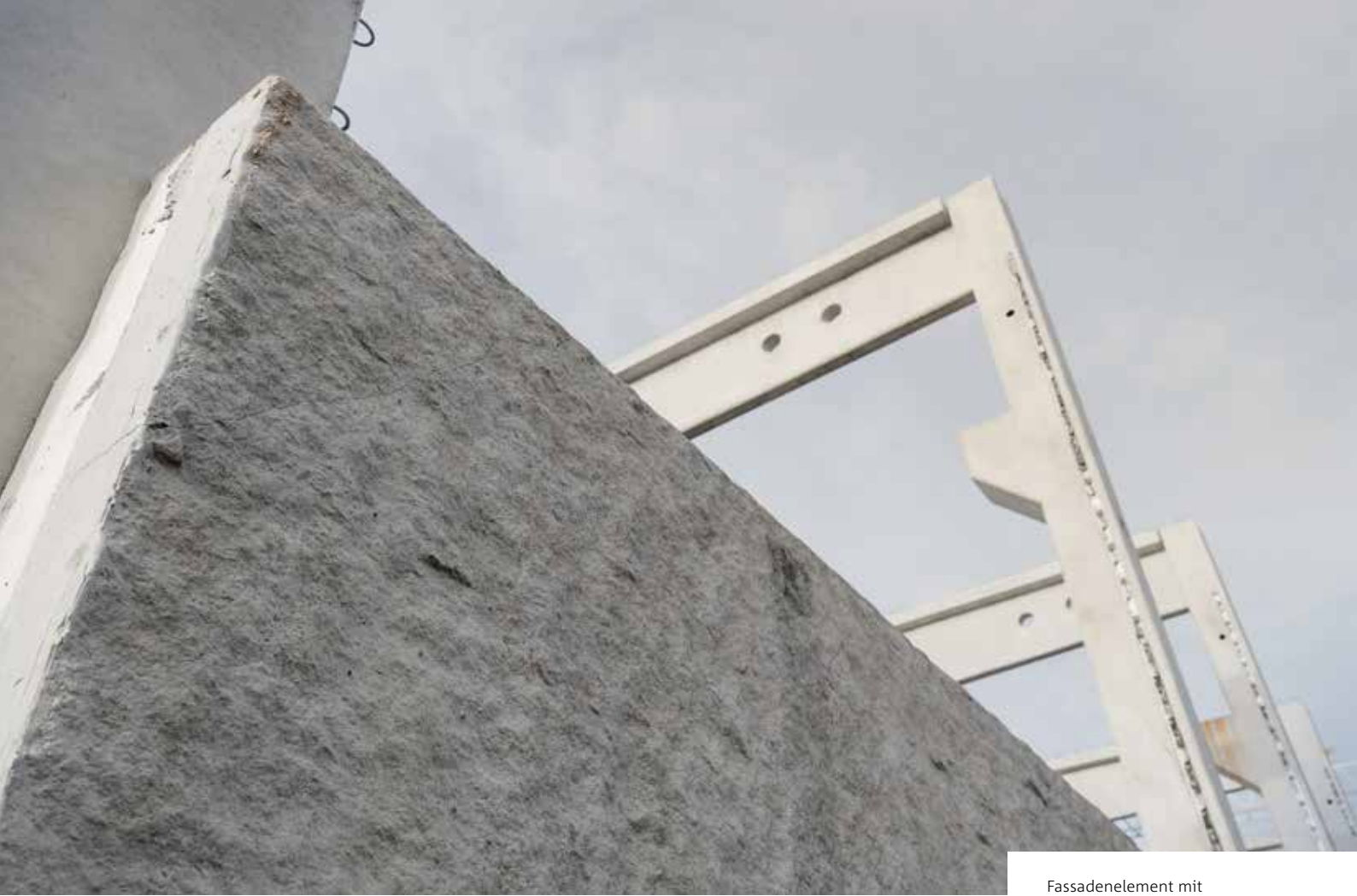
Fassadenelement mit Tragschale aus Beton, Dämmung aus expandiertem Polysterol und Vorsatzschale aus Beton
