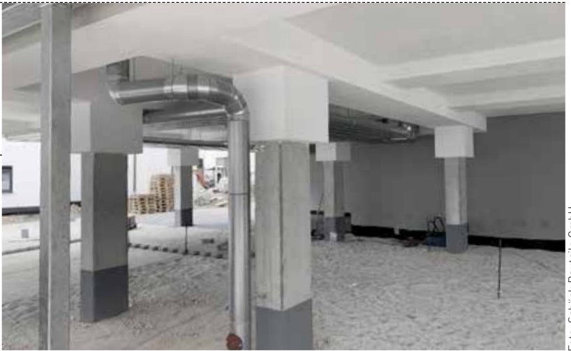
...mit flankierenden Dämmmaßnahmen
