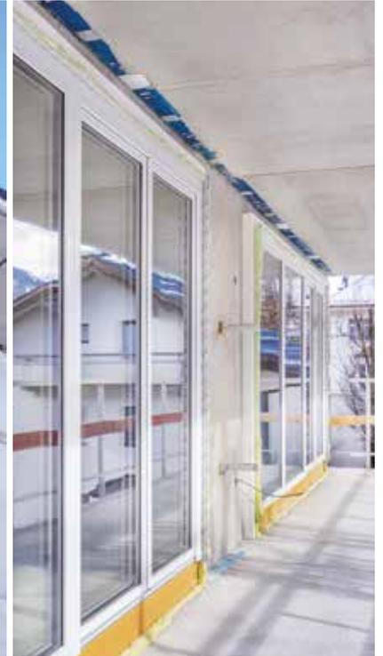
Insgesamt 542 Stück Isokorb® XT-Combar wurden im Wohnpark in Wörgl verbaut. Bei gleichzeitig 30-prozentiger Reduktion der Wärmeleitfähigkeit können rund doppelt so weit auskragende Balkone realisiert werden.
