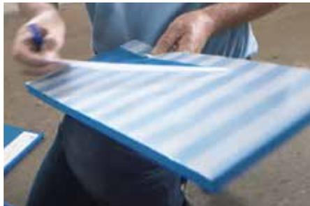
Abb. 7: Typ L Klebefolie entfernen und aufkleben
