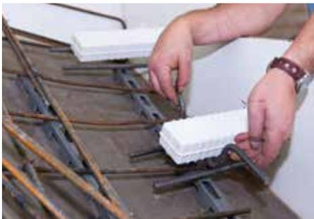
Abb. 3: Hutbügel einsetzen
