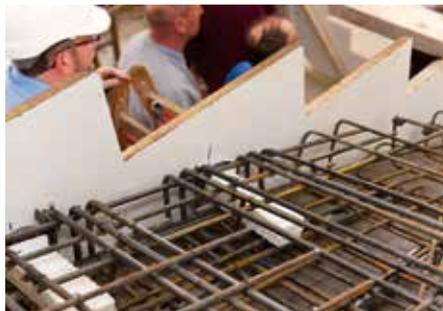
Abb. 4: Bewehrung verlegen und betonieren
