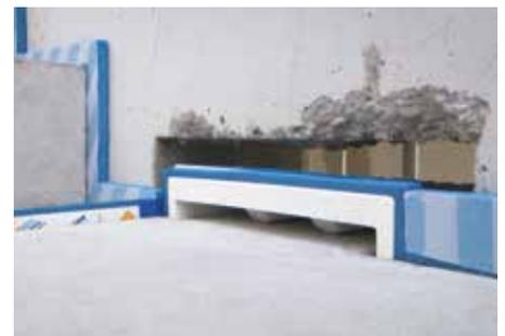
Abb. 11: Wandöffnungen mit Mörtel verfüllen
