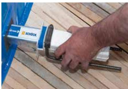
Abb. 9: Typ Q Laufhülse aufstecken
