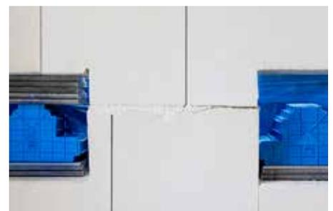
Abb. 11: Einstellung von Höhe und ggf. abhebender Kräfte mittels Ausgleichplatten
