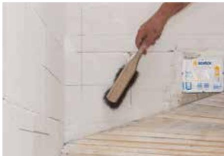
Abb. 3: Staub und Schmutz entfernen
