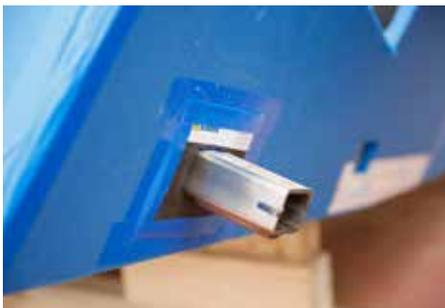
Abb. 9: Typ Q Tragelement mit Brandschutzmanschette einbauen
