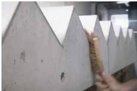
Abb. 3: Staub und Schmutz entfernen
