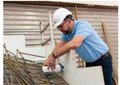
Abb. 2: Typ Q Laufhülse einbauen
