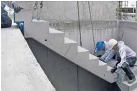
Abb. 12: Treppenlauf wird eingesetzt
