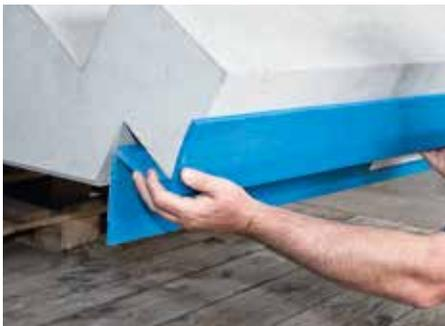
Abb. 3: Typ F ausrichten und aufkleben
