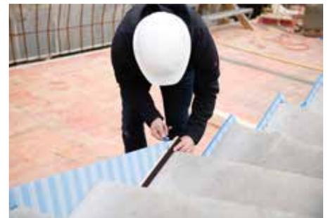
Abb. 8: Typ L mit Überstand zuschneiden
