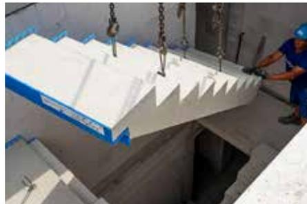
Abb. 13: Treppenlauf einheben
