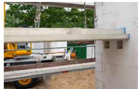
Abb. 5: Podest zwischen den Treppenhauswänden einheben
