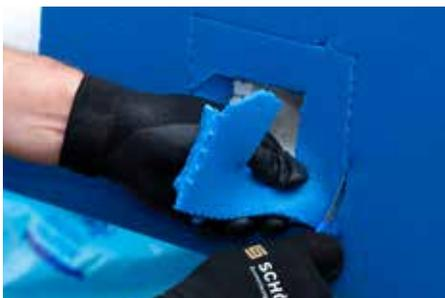
Abb. 3: Geometrie der Brandschutzmanschette ausschneiden
