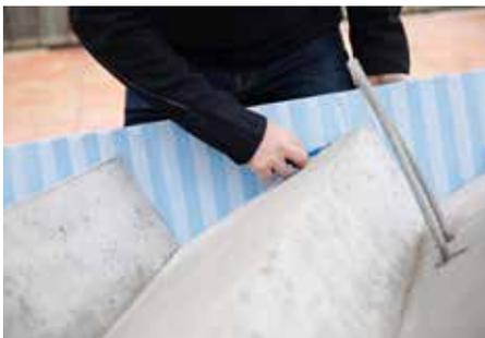
Abb. 6: Typ L Klebefolie einritzen
