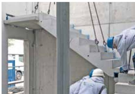
Abb. 10: Treppe einfahren und absetzen
