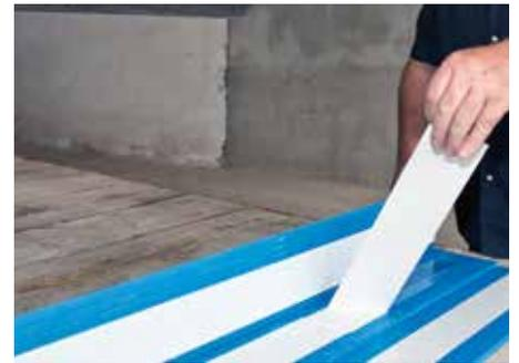
Abb. 2: Typ F Schutzfolie abziehen
