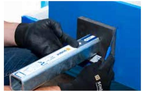
Abb. 2: Brandschutzmanschette und Tragelement positionieren
