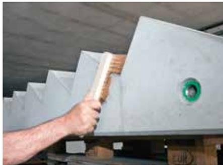
Abb. 1: Staub und Schmutz entfernen
