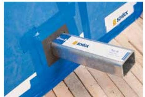
Abb. 8: Fugen mit Klebeband abdecken
