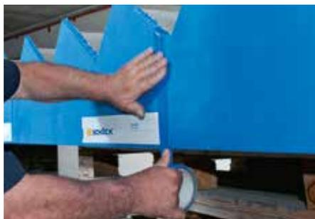
Abb. 10: Typ L Fugen mit Kleband abdecken
