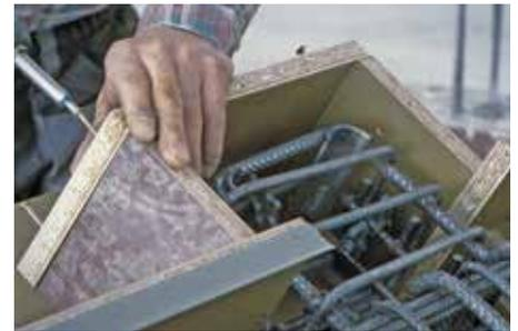
Abb. 2: Konsole fertig schalen, anschließend betonieren
