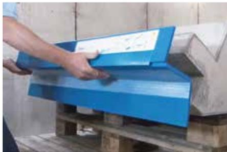
Abb. 4: Typ F ausrichten und aufkleben
