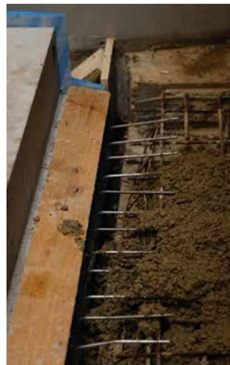
Fig. 13 : bétonner la zone de raccordement type T
