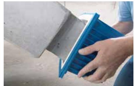
Fig. 5 : enficher l'élément mural type Z pour vérifier la géométrie
