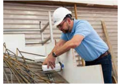
Fig. 2 : monter la gaine mobile type Q
