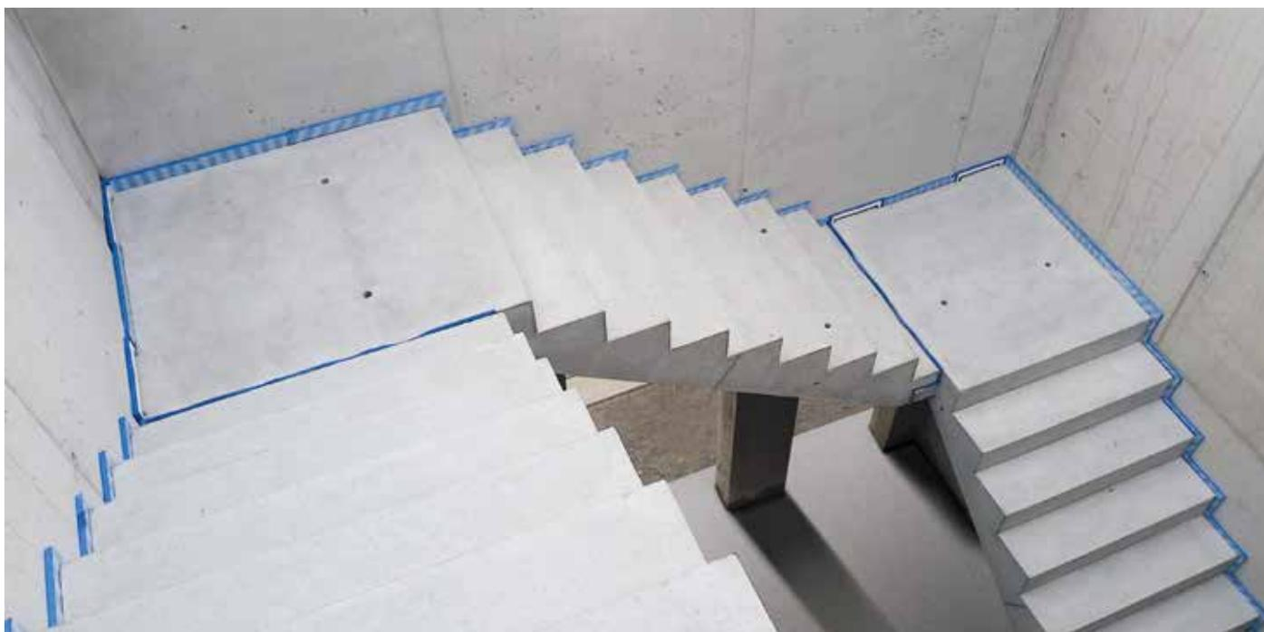
Fig. 15 : la ligne bleue est un signe de qualité certifiant l'absence de ponts acoustiques et garante d'une insonorisation optimale.
