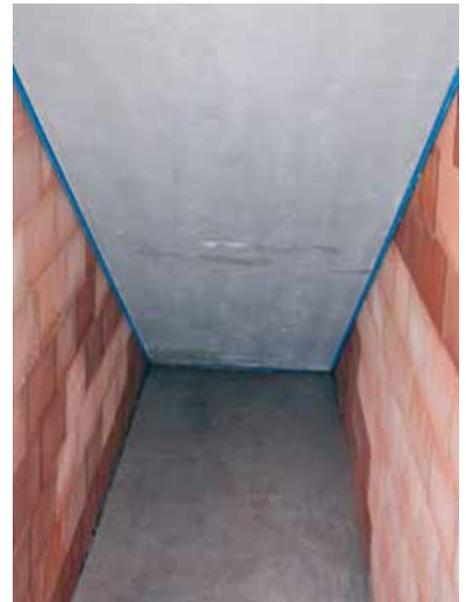
Fig. 14 : La ligne bleue est un signe de qualité certifiant l'absence de ponts acoustiques et garante d'une protection contre le bruit de choc optimale.
