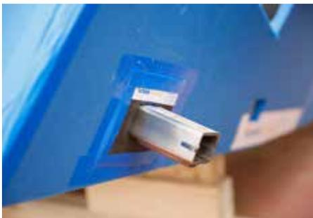
Fig. 9 : monter l'élément porteur type Q avec manchon coupe-feu
