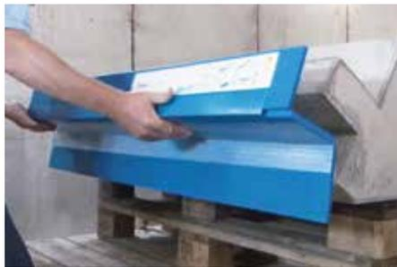
Fig. 4 : positionner et coller le type BZ
