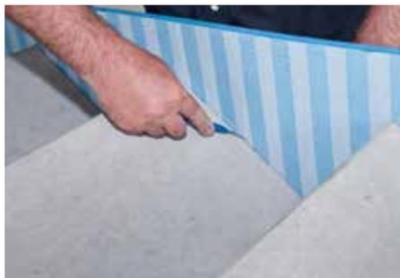
Fig. 7 : pratiquer des entailles dans le film de type L
