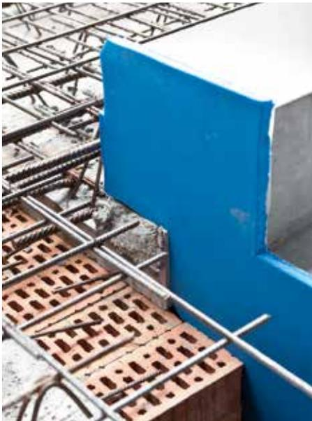
Fig. 12 : type BZ appui supérieur dalle en éléments préfabriqués
