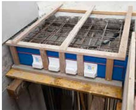
Fig. 1 : positionner et soutenir le type T
