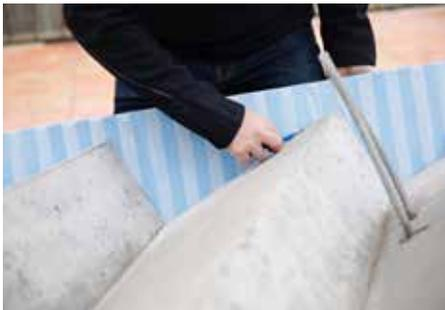
Fig. 6 : entailler le film adhésif du type L
