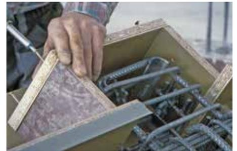
Fig. 2 : coffrer définitivement la console et bétonner
