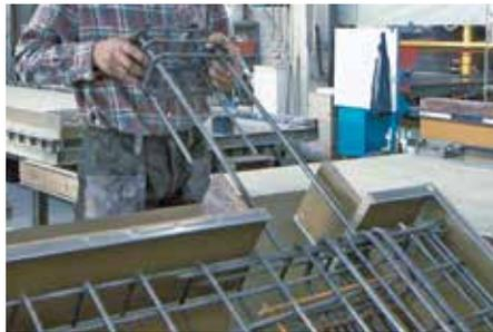
Fig. 1 : coffrer l'escalier ; utiliser le type Z, part T
