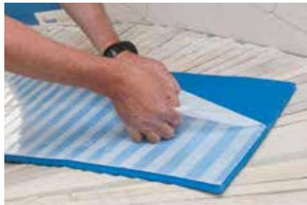
Fig. 4 : retirer de moitié le film de type L
