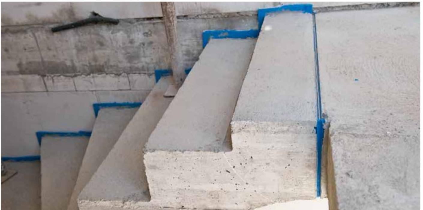
Fig. 12 : formation d'un joint droit en-haut de l'escalier
