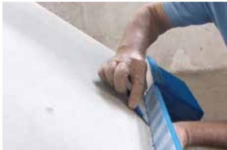
Fig. 6 : entailler le film adhésif du type L
