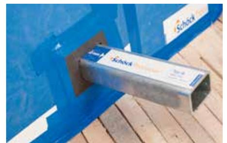
Fig. 8 : recouvrir les joints de bande adhésive
