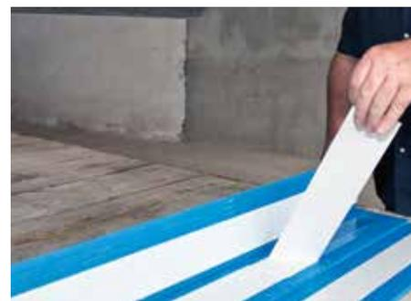
Fig. 2 : retirer le film protecteur du type BZ
