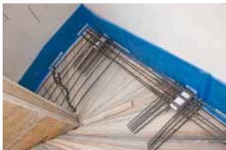
Fig. 10 : poser l'armature et bétonner
