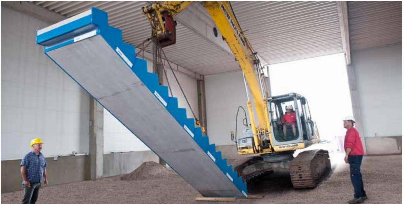
Fig. 11 : l'escalier entouré de Tronsole® type Z peut être posé directement sur le chantier.
