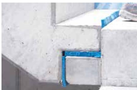
Fig. 13 : appui de console avec type BZ
