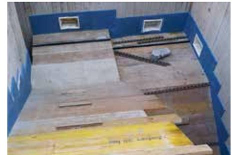
*Raccord insonorisant au mur de cage d'escalier*
