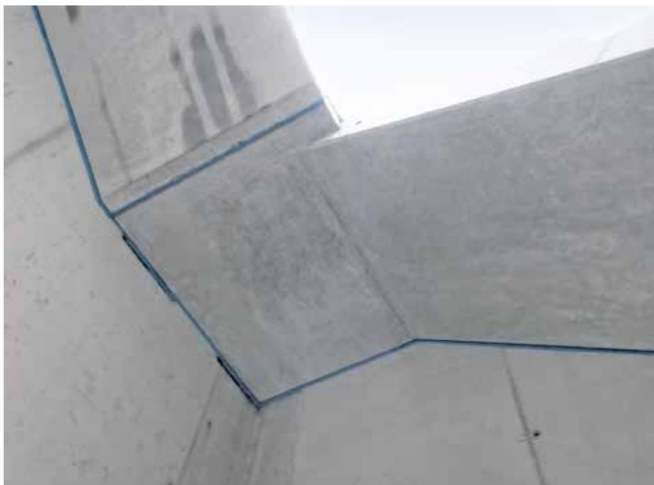
Fig. 14 : Ligne bleue régulière au niveau du joint
