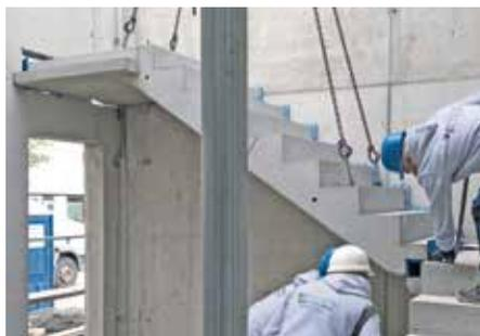
Fig. 10 : introduire et déposer l'escalier
