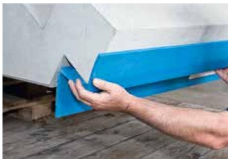
Fig. 3 : positionner et coller le type BZ
