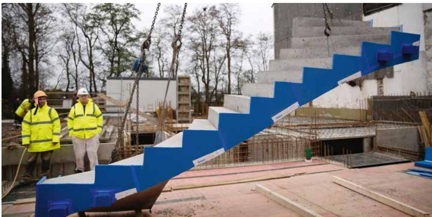
Fig. 11 : lever l'escalier et l'insérer
