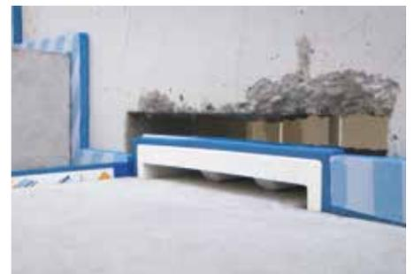
Fig. 11 : comblar les ouvertures murales avec du mortier
