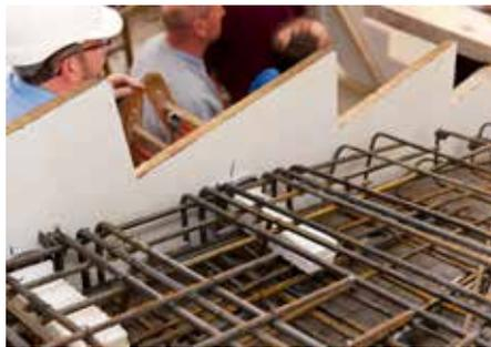
Fig. 4 : poser l'armature et bétonner
