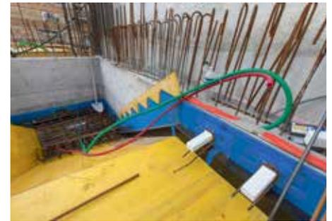
Montage Tronsole® type Q au-dessus des bandes lumineuses
