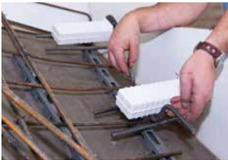
Fig. 3 : Pose de l'armature complémentaire
