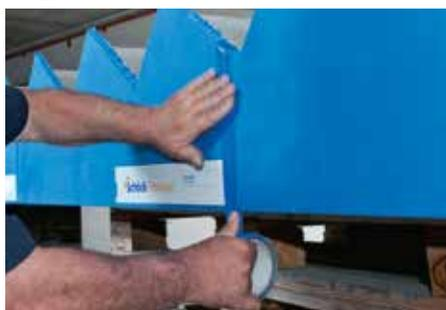
Fig. 10 : recouvrir les joints du type L de bande adhésive
