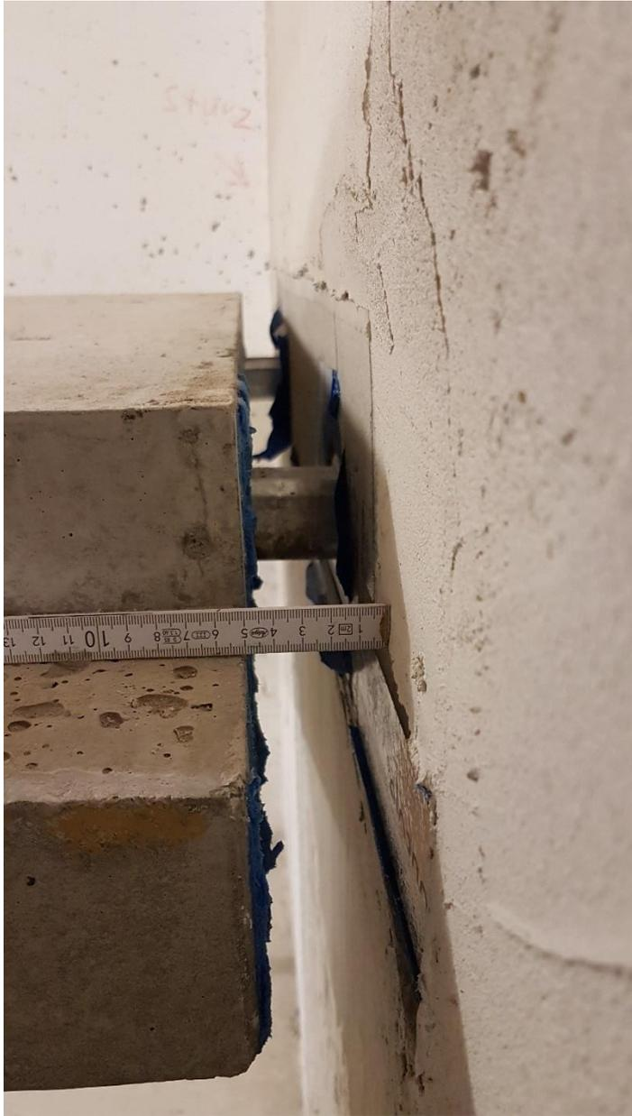
Abbildung 7: Entkoppeltes Referenztreppenpodest mit Schöck Tronsole® Typ P-VH+VH
