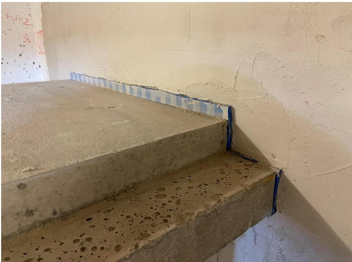
Abbildung 6: Entkoppeltes Referenztreppenpodest mit Schöck Tronsole® Typ P-VH+VH ( $z=1,5$  cm) und Fugenplatte Schöck Tronsole® Typ L-250
