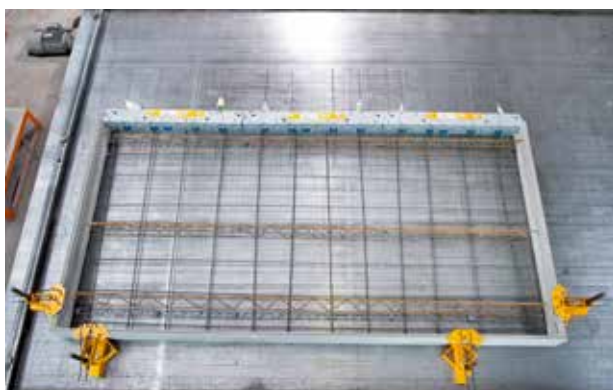
Coffrage de balcon complet avec éléments de coffrage et Schöck Isokorb®
