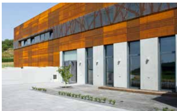
Obiekt referencyjny firmy Schöck: Winnicsa Abril, Vogtsburg-Bischoffingen w Keiserstuhl © Susanne Sommerfeld, Konstancja
