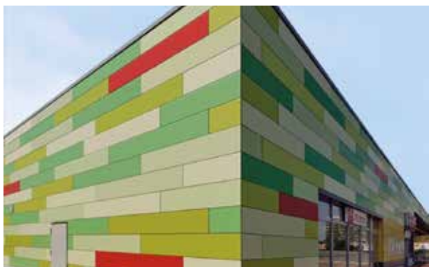
Przykład elewacji wentylowanej: Market REWE, Laatzen © AS Hibbeln GmbH
