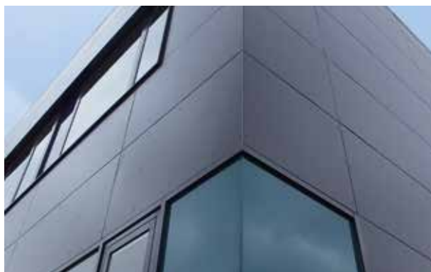
Przykład elewacji wentylowanej: Centrum edukacji w Niederschwerfen © Dach Schneider Weimar GmbH
