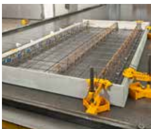
3. Place reinforcement and pour concrete
