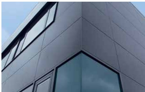
Centre de formation, Niedersachswerfen © Dach Schneider Weimar GmbH
