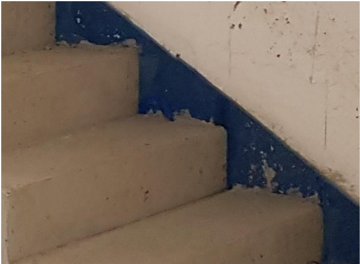
Abbildung 7: Fugenplatte Schöck Tronsole® Typ L-420 mit bauüblichem Anpressdruck eingebaut
