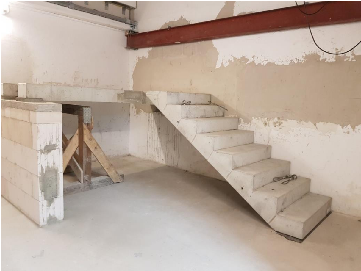
Abbildung 9: Referenztreppenlauf starr an das Referenztreppenpodest angebunden
