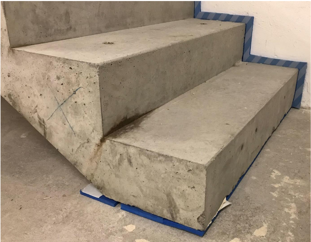
Abbildung 8: Auflagerung Fußpunkt Referenztreppenlauf mit Schöck Tronsole Typ F-V1-L1000
