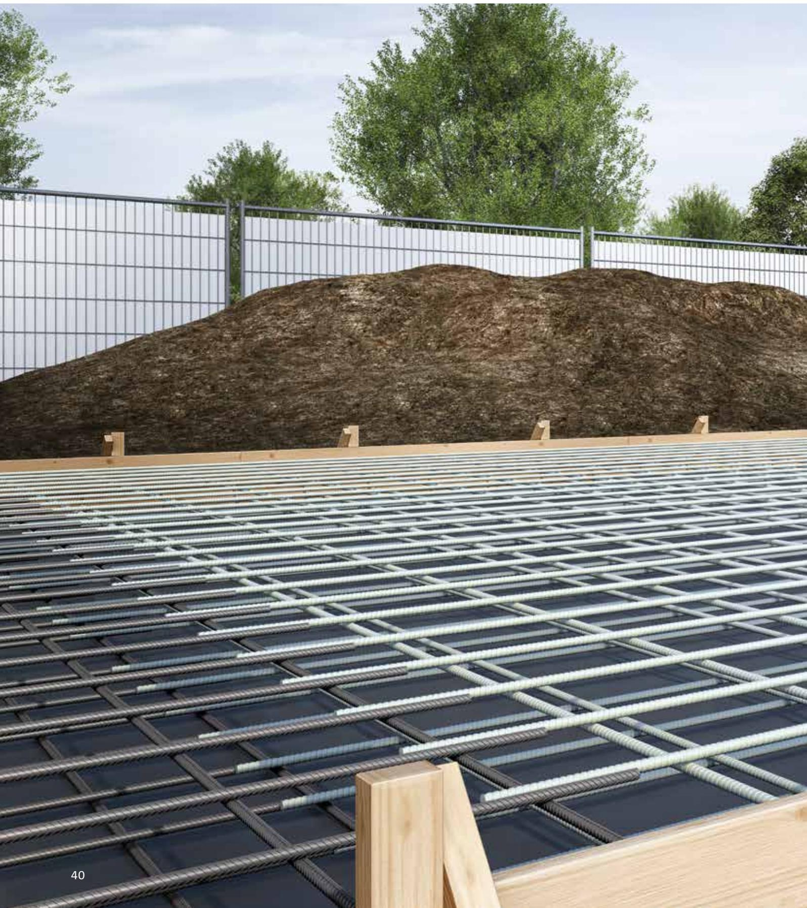
*In korrosiven Umgebungen und unter elektromagnetischem Einfluss stösst Stahlbewehrung an ihre Grenzen. Im Kern spezieller Funktionsbauten kommt deshalb Schöck Combar® zum Einsatz. Diese Glasfaserbewehrung hat ähnliche Materialeigenschaften wie Betonstahl, rostet aber nicht, ist nicht magnetisierbar und leitet weder elektrische noch thermische Ströme. Damit haben Ingenieure und Verarbeiter hochfeste und dauerhafte Bauprodukte an der Hand, die gänzlich neue Möglichkeiten bieten.*
