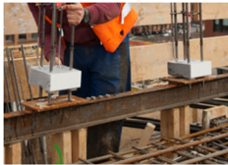
Abb. 1: Isokorb® auf Stahlschablone fixieren
