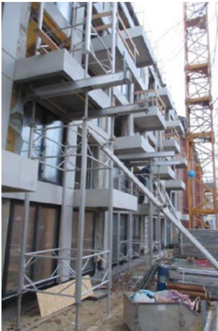
Abb. 4: Fertigteilbalkon einsetzen, justieren, abstützen
