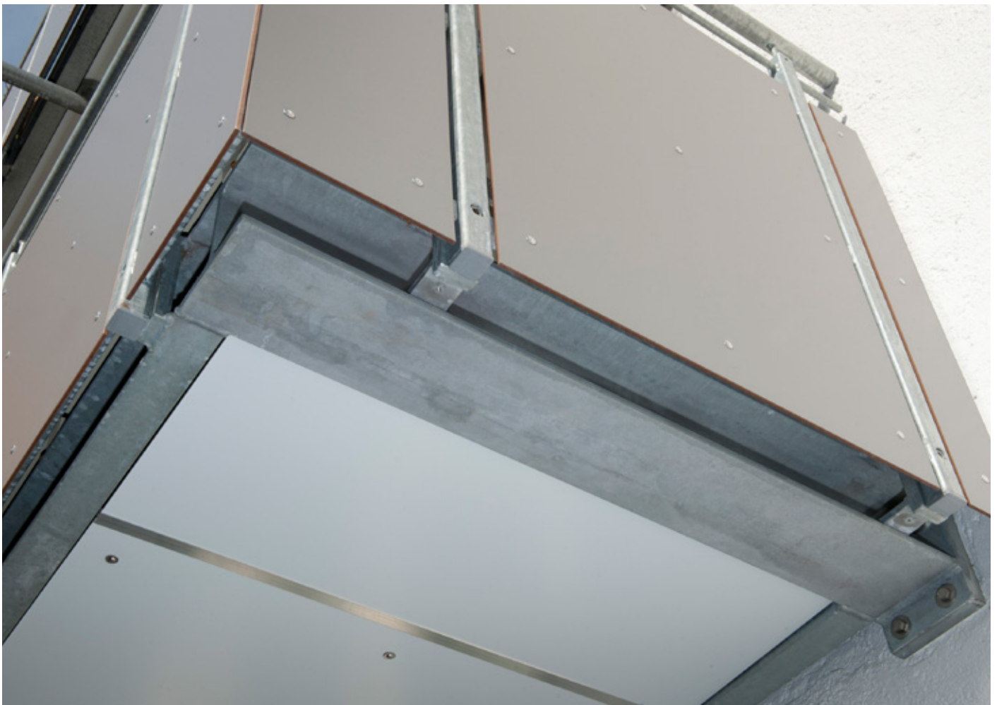
Abb. 3: Vorgefertigten Stahlbalkon mit Isokorb® verschrauben
