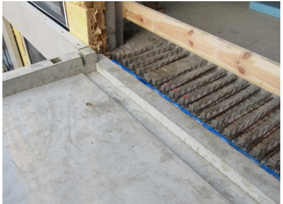
Abb. 5: Aussparungen mit Vergussmörtel verfüllen, 48 Stunden aushärten lassen
