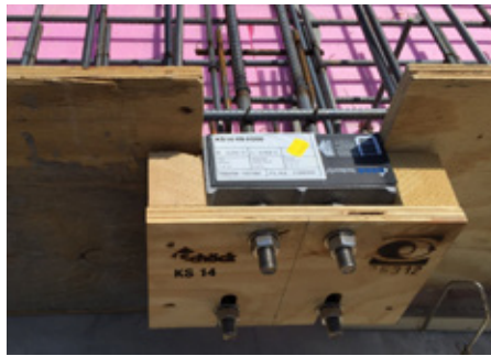
Abb. 1: Isokorb® ausrichten und fixieren mittels Einbauschablone
