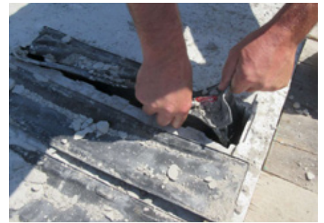
Abb.2: Decken- und Randelemente nach dem Aushärten entfernen
