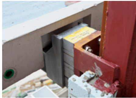
Abb. 1: Isokorb® mit Kopfplatte und Laschen,
