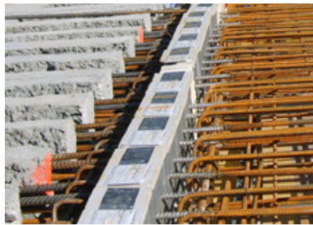
Abb. 1: In Bewehrung eingebauter Isokorb®
