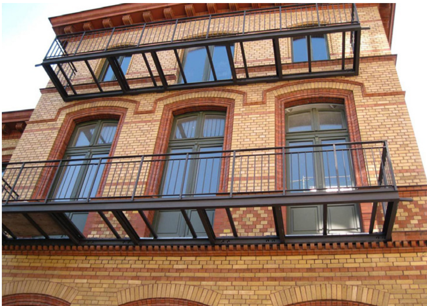
Abb. 3: Thermisch getrennter Stahlbalkon an historischer Fassade
