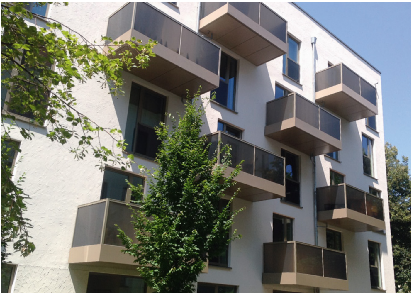
Abb. 3: Sanierungsobjekt mit thermisch getrennten Balkonen
