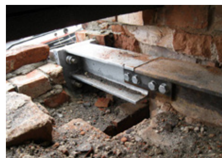
Abb. 2: neuer Balkonanschluss an bestehendem Stahlträger
