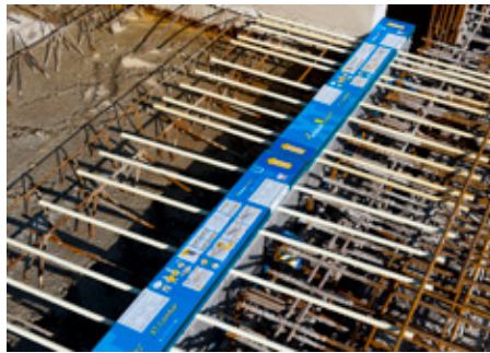
Abb. 1: Isokorb® in Bewehrung einsetzen
