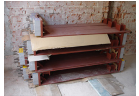
Abb. 2: Einbauteile mit Isokorb® T Typ S
