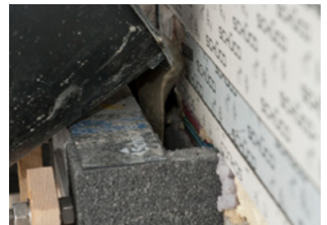
Abb. 2: Isokorb® einkleben und Vergusstasche kraftschlüssig verfüllen
