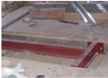
Abb. 1: Rückverankerung des Balkons in die Holzbalkendecke
