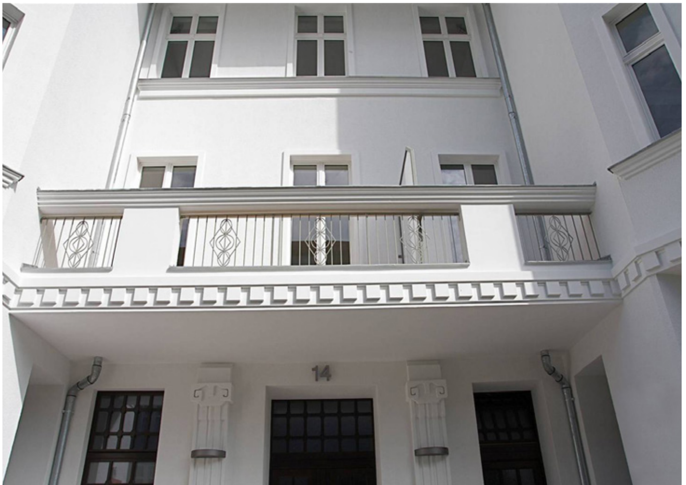
Abb. 3: Denkmalgerecht sanierter und thermisch getrennter Balkon
