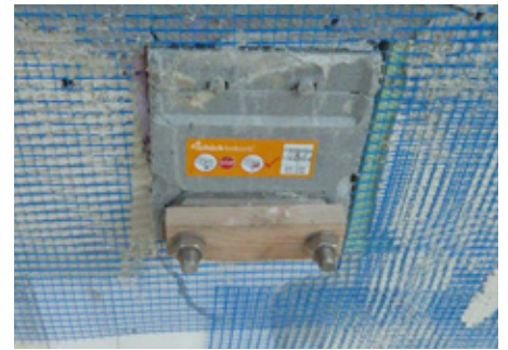
Abb. 2: Wärmedämmung aufbringen und verputzen
