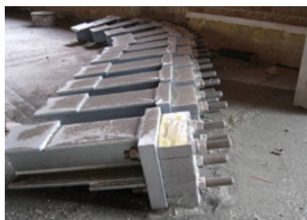
Abb. 1: neuer Balkonanschluss mit Isokorb® T Typ S
