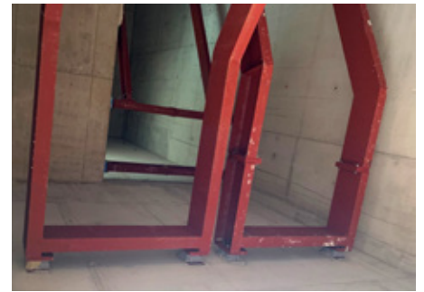
Abb. 2: Blick in den Treppenraum
