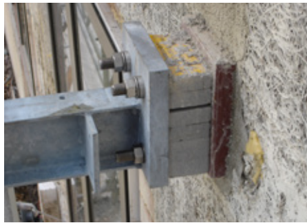
Abb. 1: Neuer Balkonanschluss mit Isokorb® T Typ S
