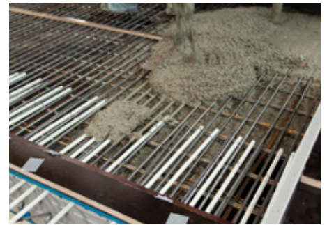
Abb.2: Decke und Balkonplatte betonieren
