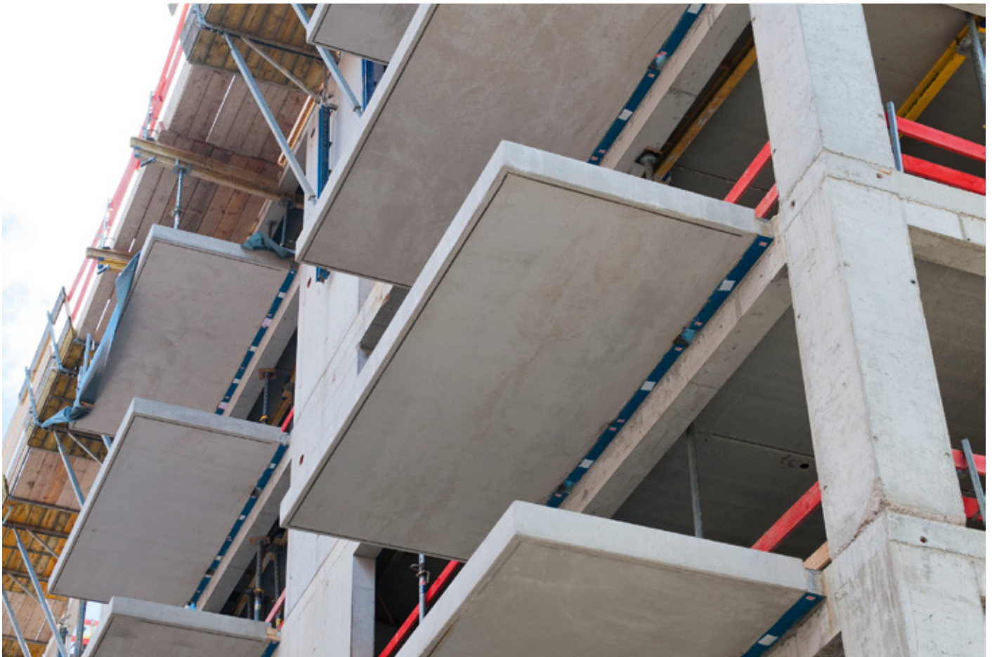
Abb. 3: Ausgeschalte Balkonplatten
