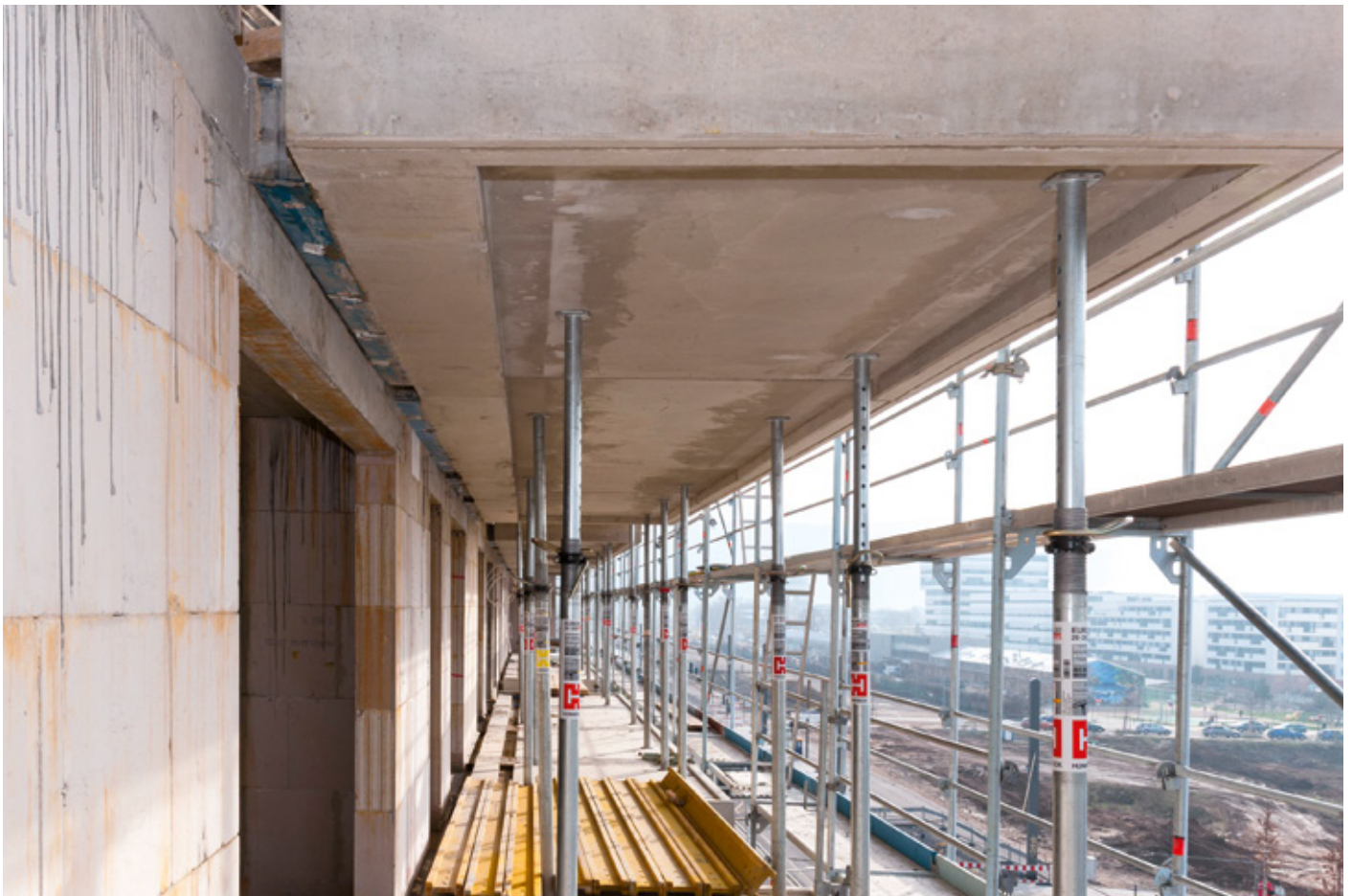
Abb. 3: Balkonplatten bis zur Endfestigkeit abstützen
