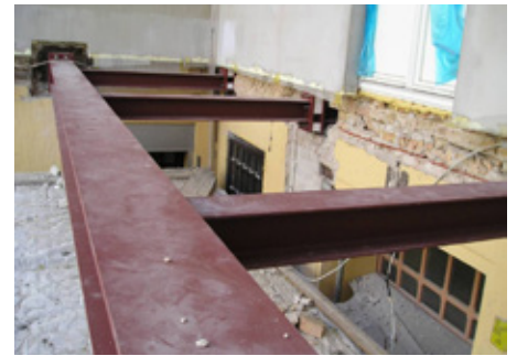
Abb. 2: Thermisch getrenntes Tragwerk des neuen Balkons
