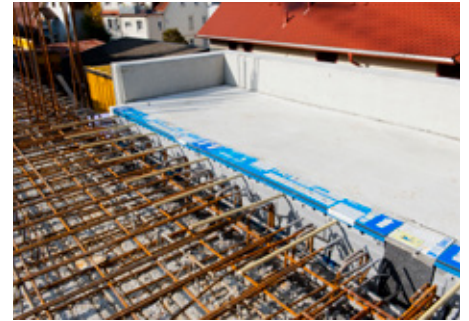
Abb. 2: Einbau in Decke, Abstützen des Fertigteils
