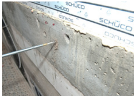
Abb. 1: Bohrungen in Decke herstellen und reinigen
