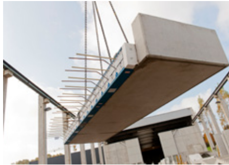
Abb. 1: Anlieferung des Fertigteils auf die Baustelle
