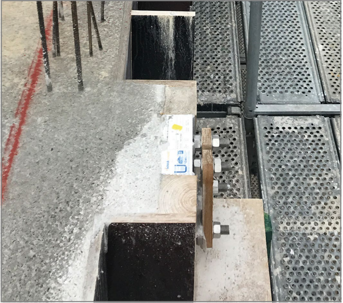
Abb. 20: Schöck Isokorb® XT Typ SK mit aufgesteckter Einbauhilfe
