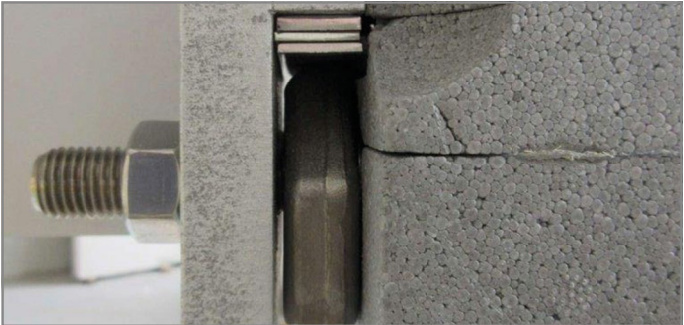
Abb. 49: Auflegen der Stahlkonstruktion mit den am Produkt angebrachten Unterlegplättchen zum Höhenausgleich
