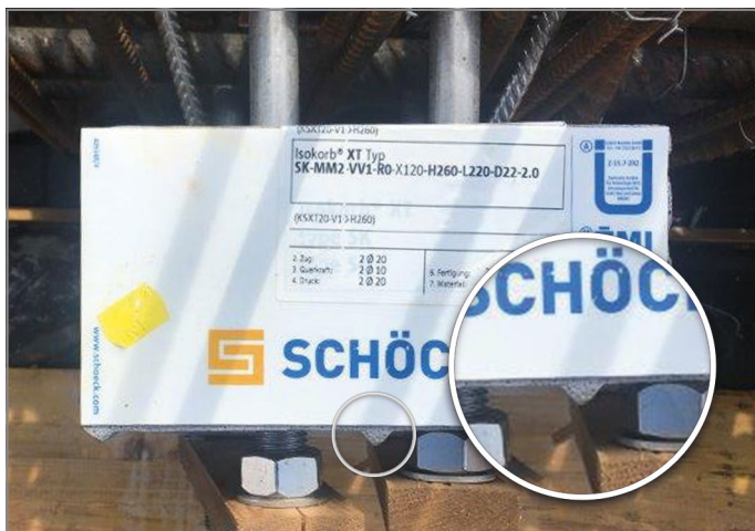
Abb. 25: Mittenkennzeichnung beim Schöck Isokorb® XT/T Typ SK
