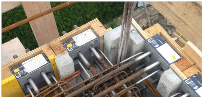
Abb. 44: Einbau bei Außenecken
