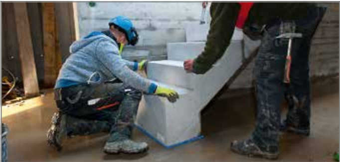
Abb. 121: Treppe absetzen
