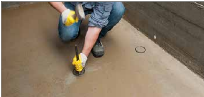
Abb. 115: Kernbohrung ausbrechen
