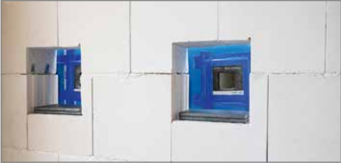
Abb. 39: Podest auf Höhe der Wandaussparungen positionieren
