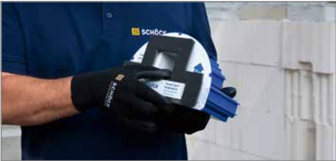
Abb. 41: Brandschutzabdeckung am Wandelement aufkleben
