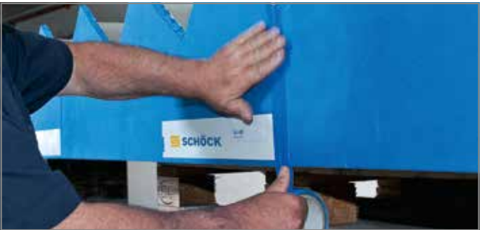
Abb. 142: Stöße von Tronsole® Typ L verkleben
