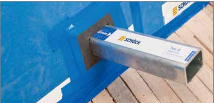
Abb. 67: Traglelement montieren und Brandschutzmanschette abkleben
