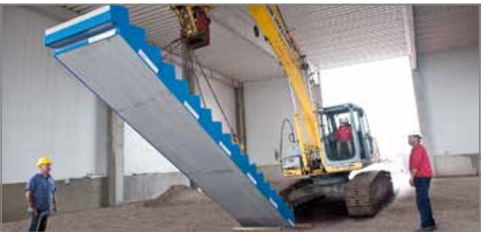
Abb. 143: Vorbereitete Treppe einsetzen
