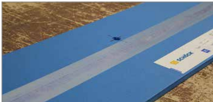
Abb. 116: Position von Tronsole® Typ D einzeichnen und ausschneiden
