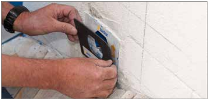
Abb. 61: Brandschutzabdeckung aufkleben
