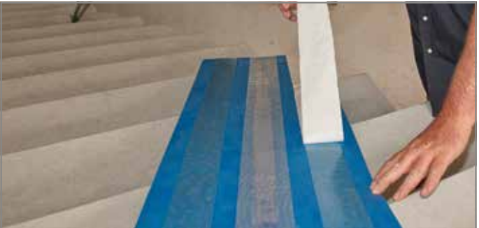
Abb. 109: Schutzfolie von Tronsole® Typ B abziehen
