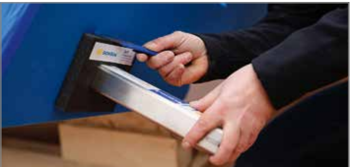
Abb. 74: Geometrie der Brandschutzmanschette ausschneiden
