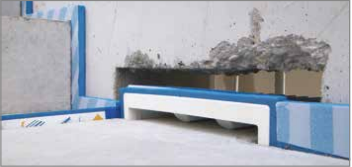
Abb. 57: Wandaussparung vergießen
