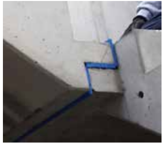
Abb. 3: Blaue Linie zeigt durchgängige Entkopplung
