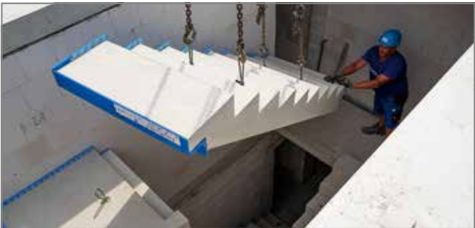
Abb. 47: Treppenlauf einheben
