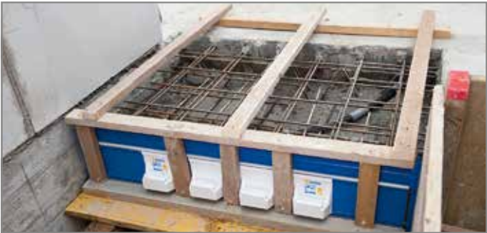
Abb. 93: Vor dem Betonieren
