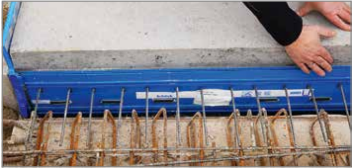
Abb. 96: Treppe einsetzen und stützen
