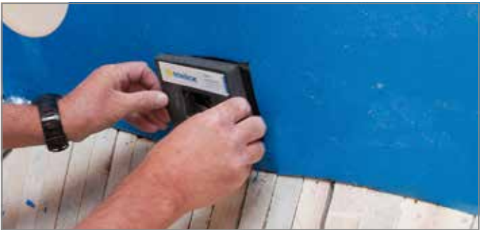
Abb. 66: Brandschutzmanschette einsetzen
