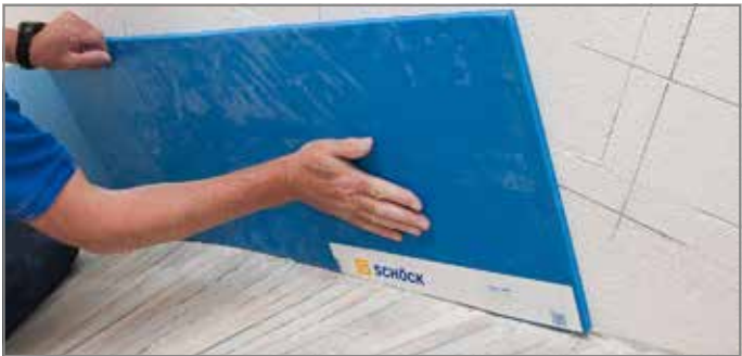
Abb. 129: Tronsole® Typ L aufkleben
