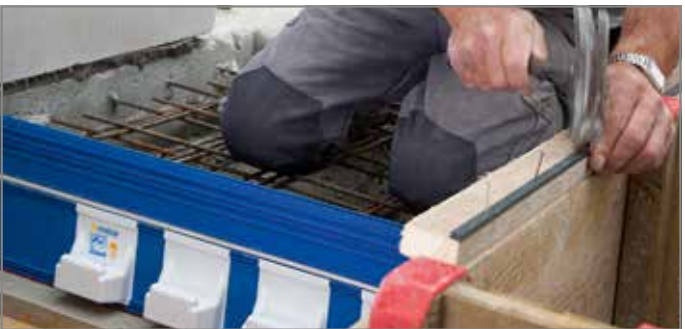
Abb. 90: Obere Nagelleiste anbringen
