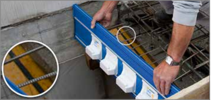
Abb. 88: Tronsole® Typ T einsetzen
