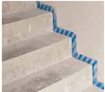
Abb. 5: Blaue Linie zeigt durchgängige Entkopplung
