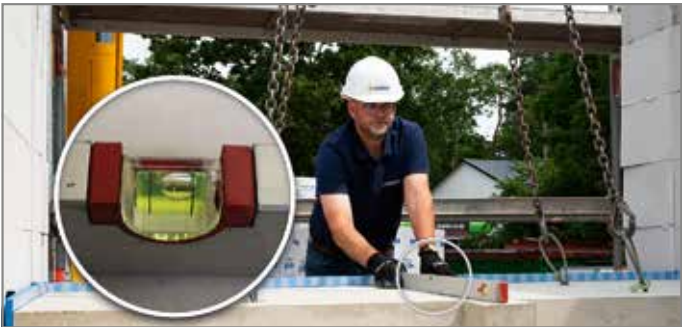
Abb. 46: Einfederung gemäß Technischer Information berücksichtigen
