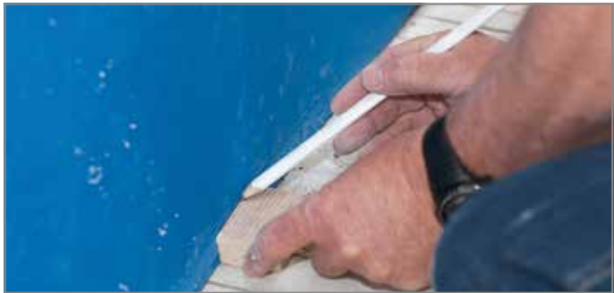
Abb. 125: Unteres Laufprofil von Tronsole® Typ L anzeichnen
