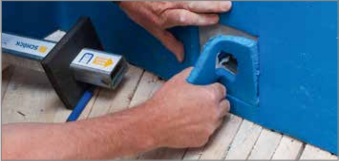
Abb. 65: Ausschnitt für die Brandschutzmanschette entfernen
