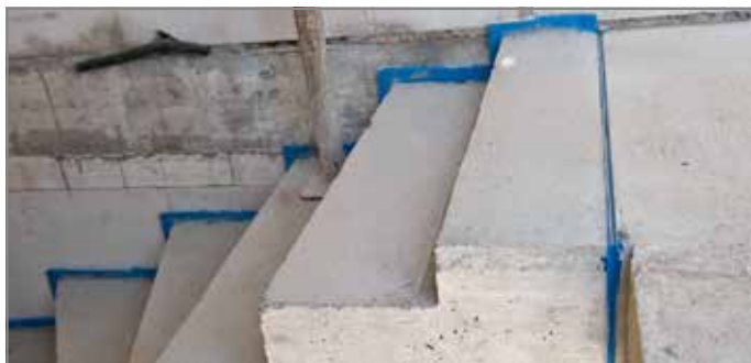
Abb. 134: Gerade Fugenausbildung am Treppenaustritt
