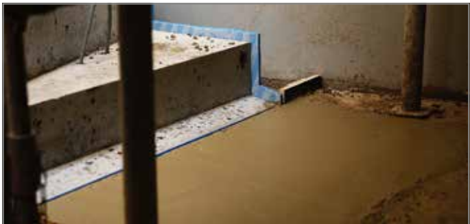
Abb. 98: Anschlussbereich betoniert
