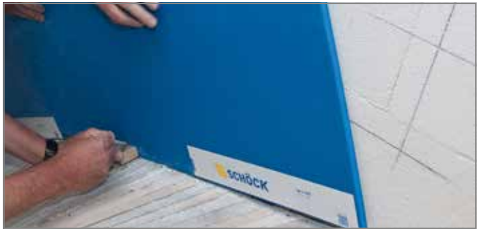
Abb. 124: Unteres Laufprofil von Tronsole® Typ L anzeichnen
