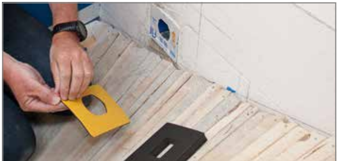
Abb. 60: Bei Brandschutzanforderung R 90 die Schutzfolie der Brandschutzabdeckung abziehen
