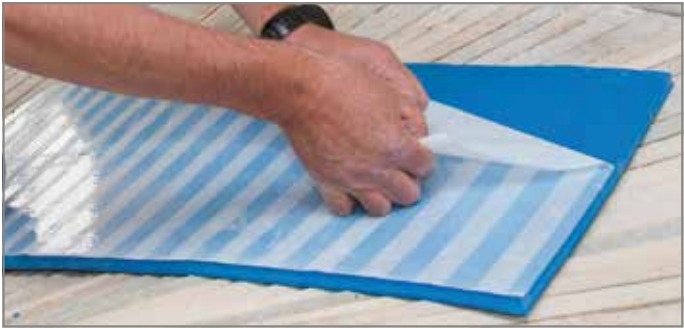
Abb. 128: Schutzfolie von Tronsole® Typ L zur Hälfte oder circa 150 mm entfernen
