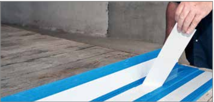
Abb. 104: Schutzfolie von Tronsole® Typ F abziehen
