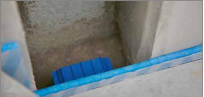
Abb. 85: Aussparung vergießen
