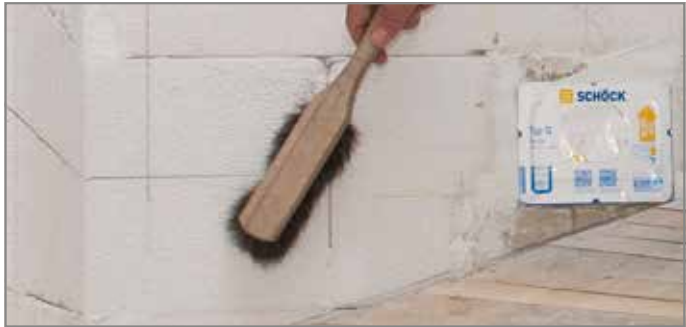
Abb. 123: Staub und lose Teile entfernen
