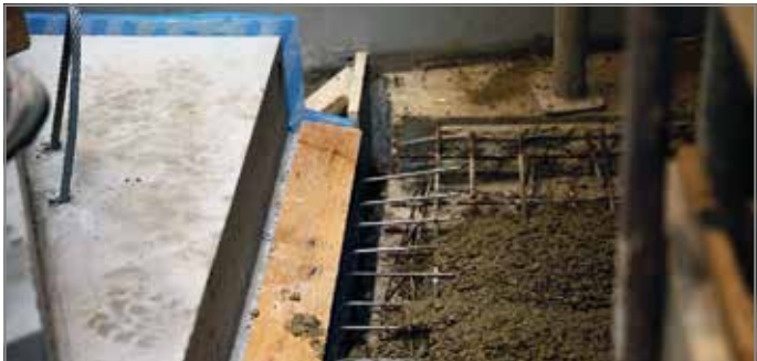
Abb. 97: Anschlussbereich betonieren
