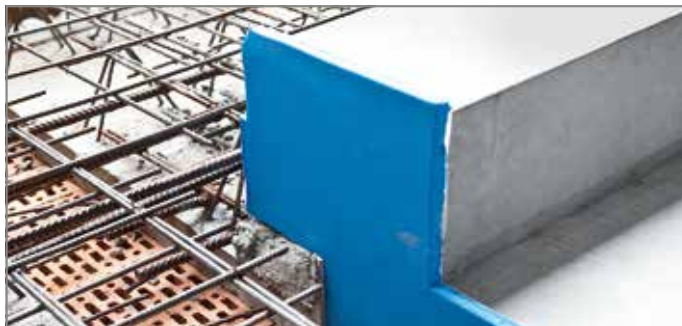
Abb. 144: Oberes Auflager der Treppe kontrollieren
