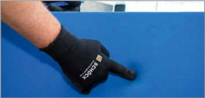
Abb. 33: Aussparung der Podesthülse ertasten
