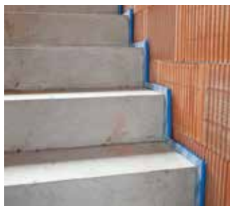
Abb. 9: Schöck Tronsole® trennt die Bauteile vollflächig und minimiert die Gefahr von Schallbrücken.
