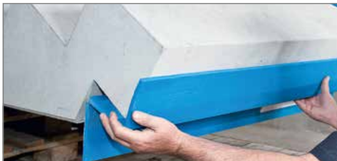
Abb. 105: Obere Schenkel von Tronsole® Typ F ankleben
