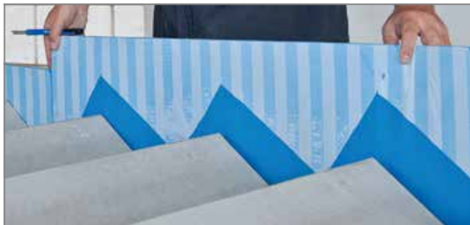
Abb. 138: Tronsole® Typ L ankleben
