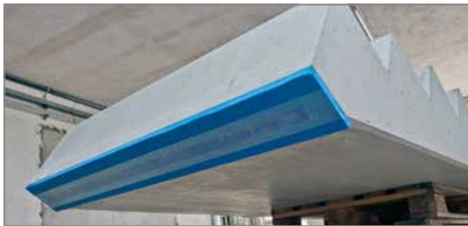
Abb. 112: Tronsole® Typ B aufgeklebt
