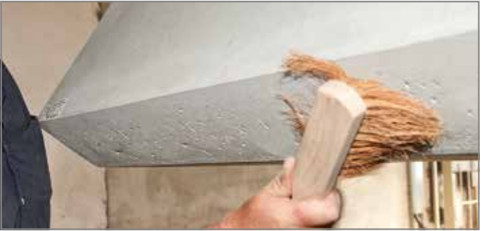
Abb. 108: Staub und lose Teile entfernen
