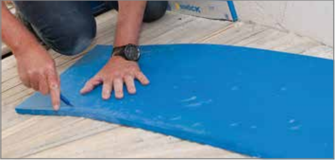
Abb. 126: Unteres Laufprofil von Tronsole® Typ L zuschneiden
