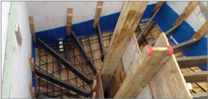
Abb. 130: Treppenlauf bewehren und Stufenbretter anbringen
