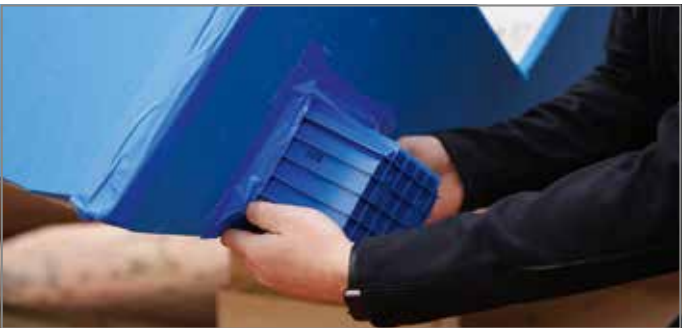
Abb. 80: Wandelement für Einbauzustand waagerecht ausrichten und abkleben
