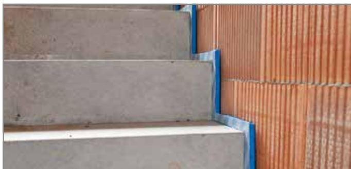
Abb. 145: Überstand der Fugenplatte kontrollieren
