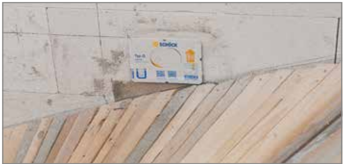
Abb. 59: Wandelement Tronsole® Typ Q in KS-Wand eingemauert
