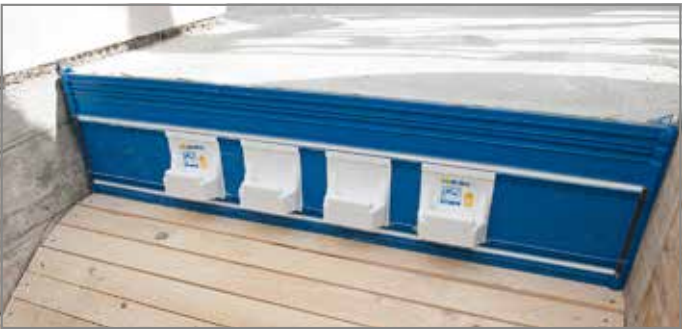
Abb. 95: Oberer Anschluss mit Tronsole® Typ T
