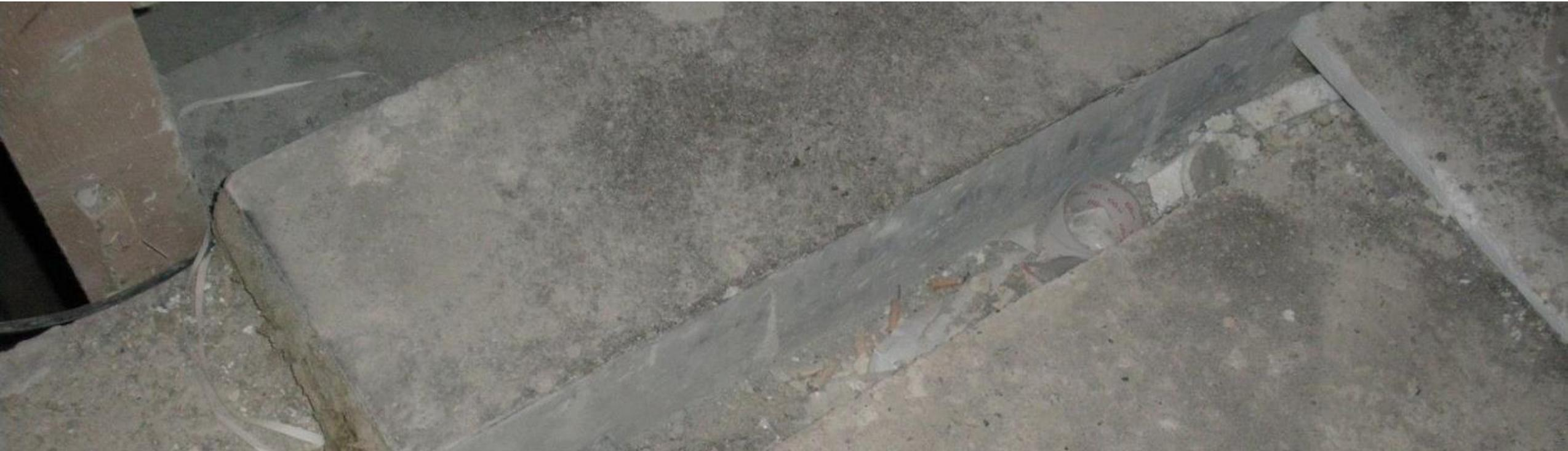
**1 Kieselstein reduziert die Schalldämmung um ca. 10 dB**
