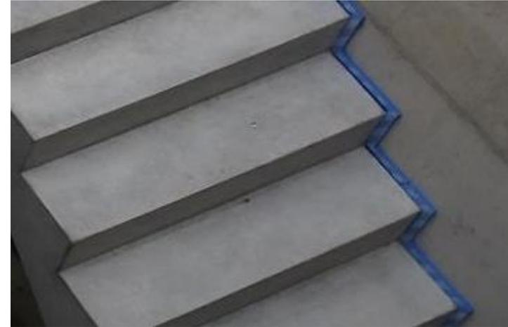
**Vollflächige Trennung und Minimierung der Schallbrücken-Gefahr.**
