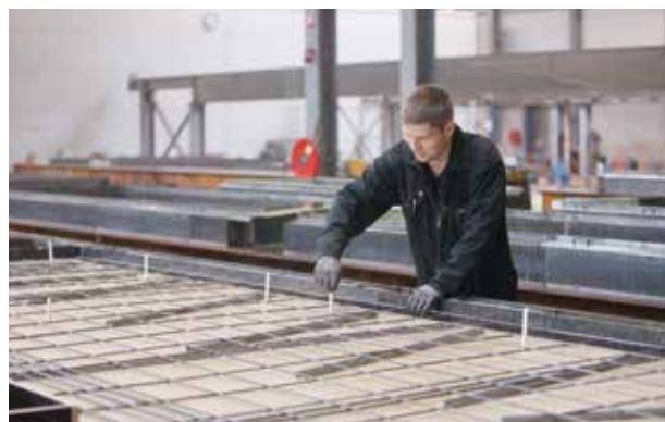
Étape 4 : Insertion des tiges Isolink dans les trous préforés et la coque en béton toute fraîche.
