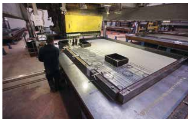
Étape 2 : La première coque en béton du mur sandwich est coulée.
