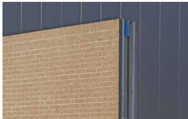
Étape 6 : Le mur sandwich isolé dans le noyau est prêt à être transporté sur le chantier.
