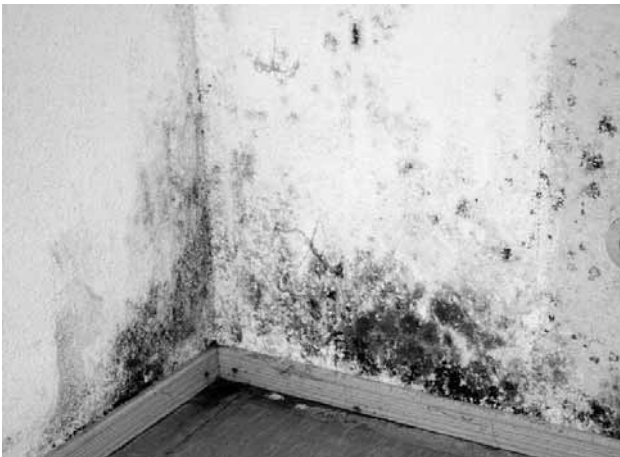
Beispiele für Schimmelpilzbefall im Wärmebrückenbereich.
