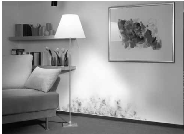
Beispiele für Schimmelpilzbefall im Wärmebrückenbereich.
