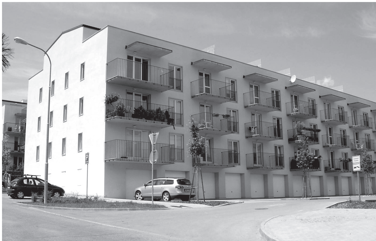
Bytový dům Optátova, Brno - Jundrov
