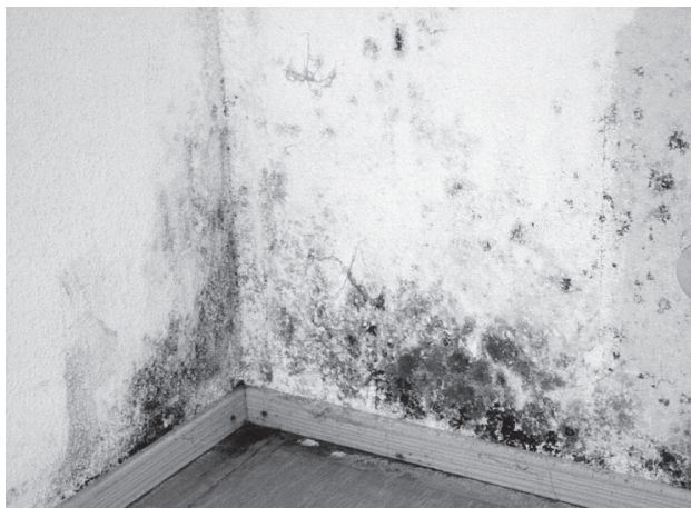
Příklady napadení plísněnými škůdci v oblasti tepelných mostů.
