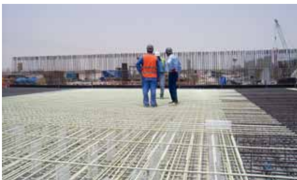
Выпрямляющая решетка опорной плиты, алюминиевый завод Qatalum, Катар
