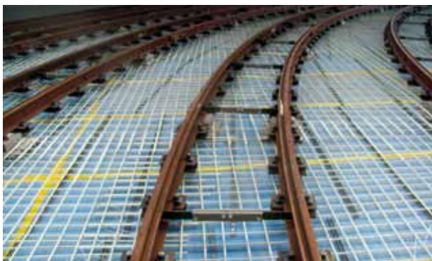
Опорная плита в железнодорожном депо, Базель, Швейцария
