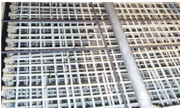
Фундамент для трансформатора Reiner Träger GmbH, Пейне, Германия
