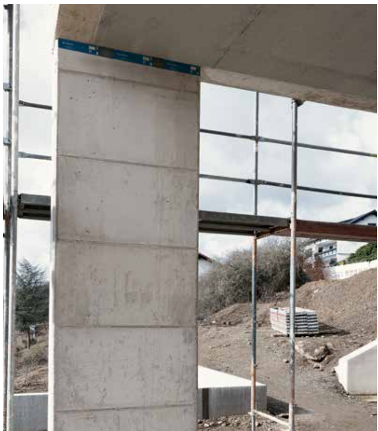
Sconnex® ermöglicht schlanke Wandvorlage in Sichtbetonoptik bei nachhaltig gelöster Wärmebrücke.
