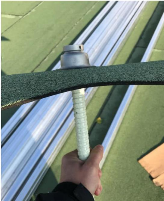
Andichtbahn mit Dachkonsole
