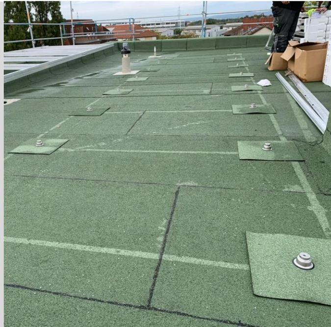
Dachkonsole ROOFLink nach dem
