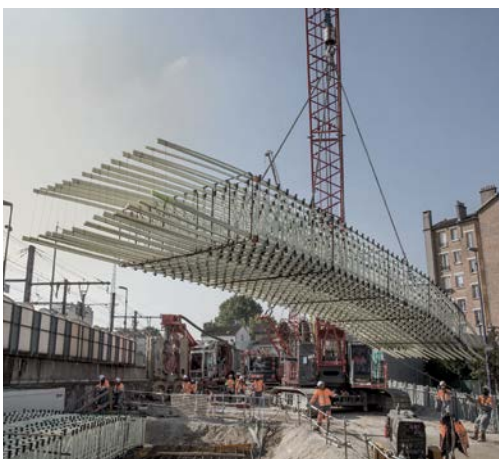
パリ地下鉄15号線のトンネル工事
