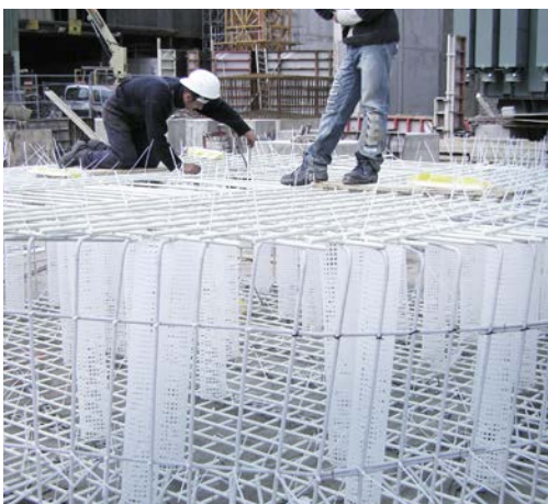
Peiner Träger社の開閉装置の基礎補強 ドイツ、バイエルン
