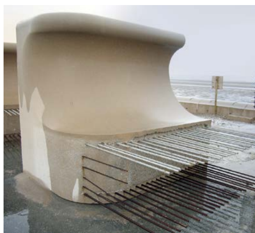
ビーチ遊歩道沿いのプレキャスト部材 ブラックプール、イギリス
