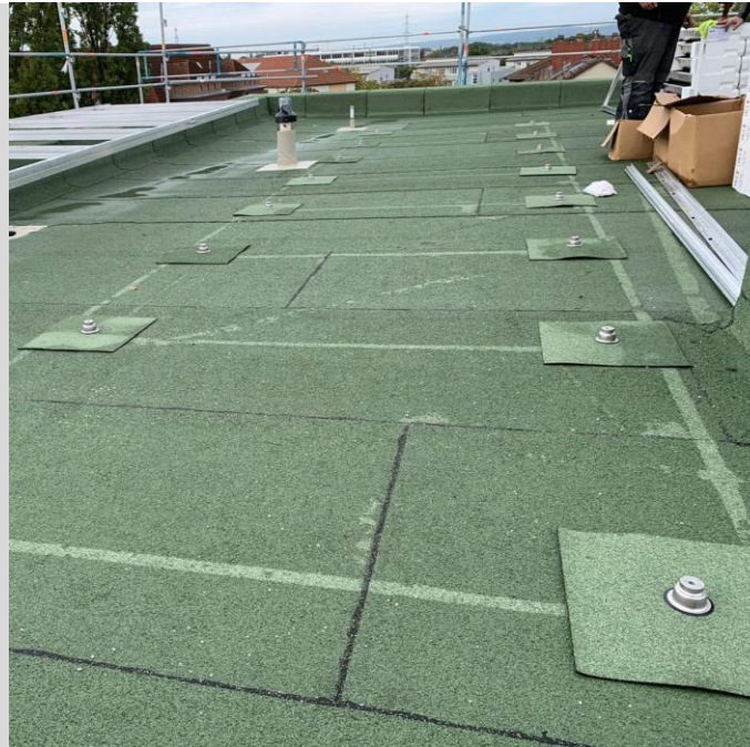
Dachkonsole ROOFLink nach dem Setzen und vor dem Verschweißen der Andichtbahn.
