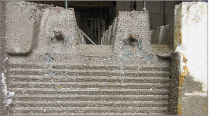
Afb. 46: Vloer na verwijderen van het Schöck IDock®-vloerelement met zichtbare aansluitwapening
