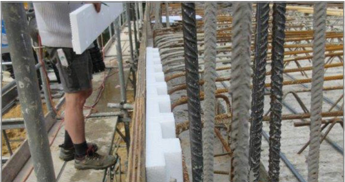
Afb. 24: Snijd het randelement op maat en bevestig het
