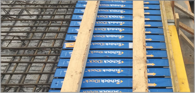
Afb. 31: Houd het met stutbalken of steigerplanken op zijn plaats
