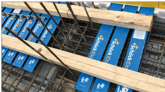
Afb. 33: Vloer voorbereid voor het betonneren
