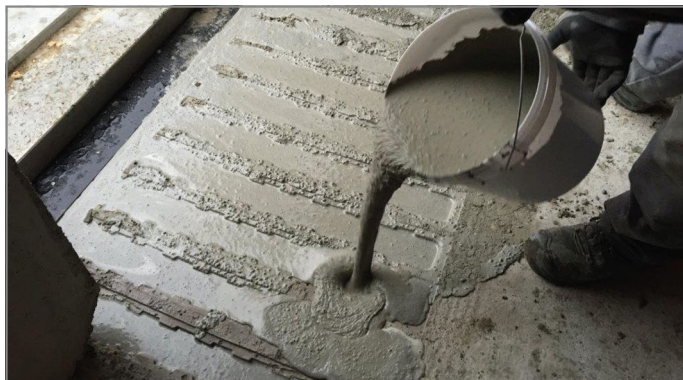
Afb. 65: Betonmortel gieten
