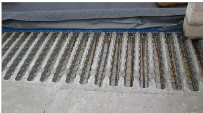
Afb. 49: Vloer na verwijderen van het Schöck IDock®-vloerelement, met Schöck Isokorb®
