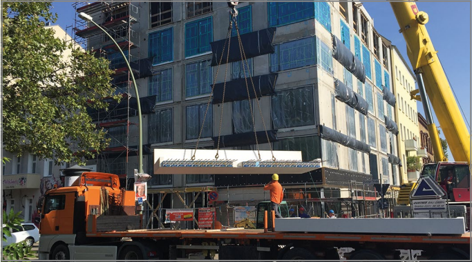
Afb. 58: Levering van de prefabbalkons
