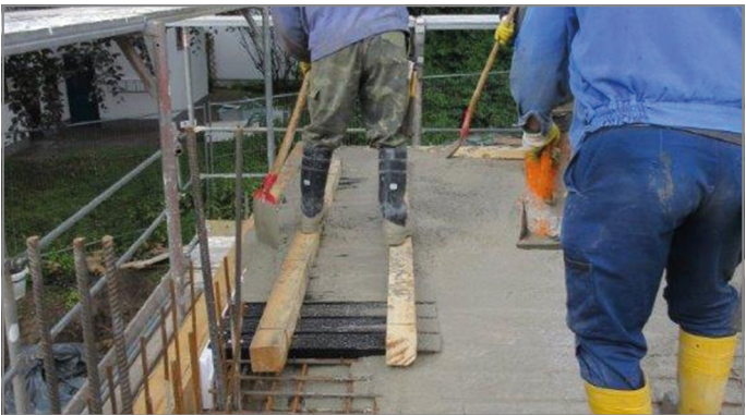
Afb. 36: Voortschrijdend verloop van de betonning op het vloerelement
