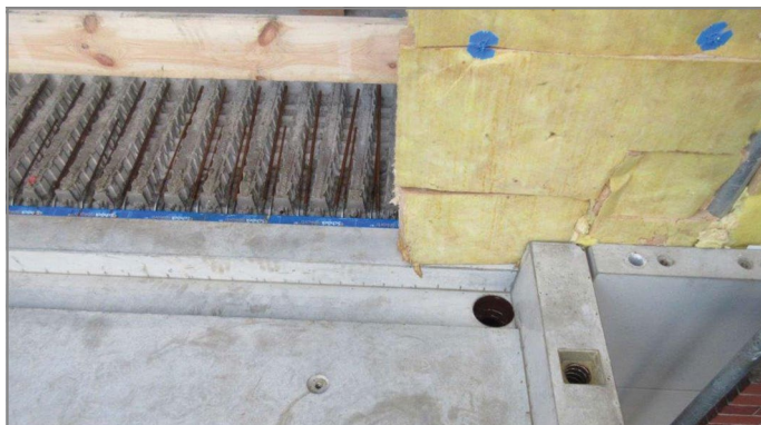
Afb. 61: Prefabplaten correct in de vloeruitsparingen gelegd, gezien vanaf het balkon
