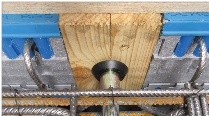
Afb. 18: Detailweergave: Uitsparing voor hijsanker
