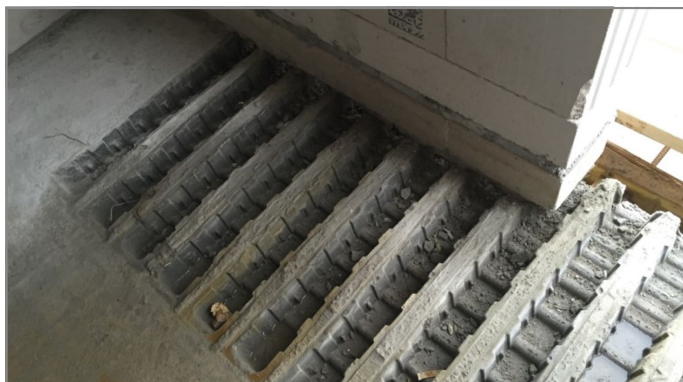
Afb. 45: Metselwerk met ontkiste uitsparingen, detailweergave
