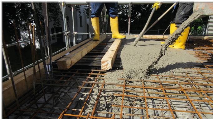
Afb. 34: Op het Schöck IDock®-vloerelement betonneren
