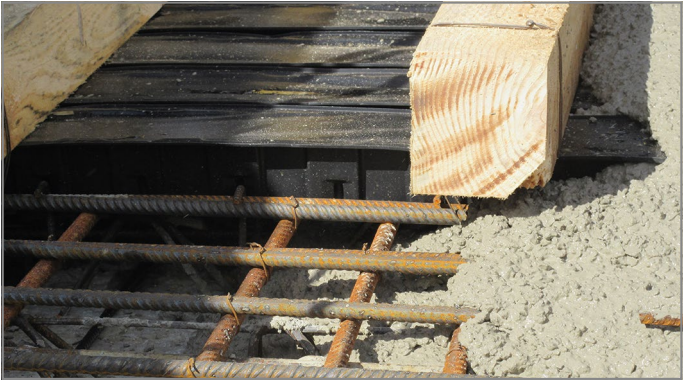
Afb. 35: Detailweergave: Op het Schöck IDock®-vloerelement betonneren
