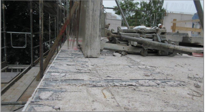
Afb. 39: Muurbekisting met ter plaatse gestort beton
