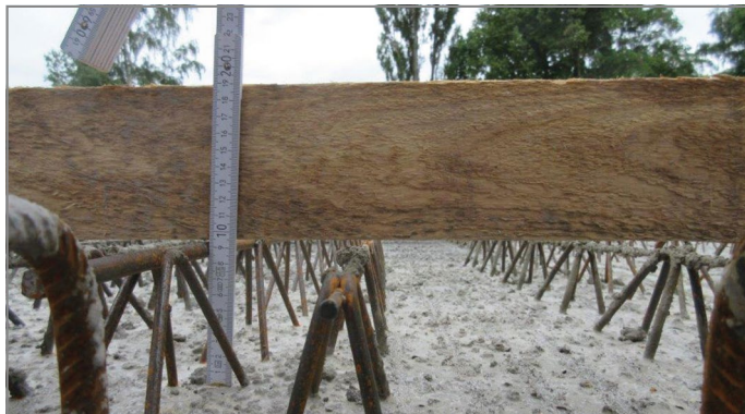
Afb. 25: Let op de hoogte van de tralieliggers
