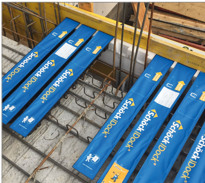
Afb. 30: Plaats het vloerelement in de juiste positie en controleer of het 100% horizontaal ligt
