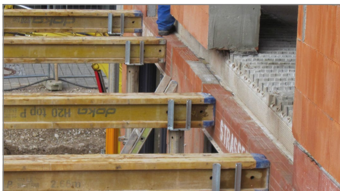
Afb. 44: Metselwerk met ontkiste uitsparingen
