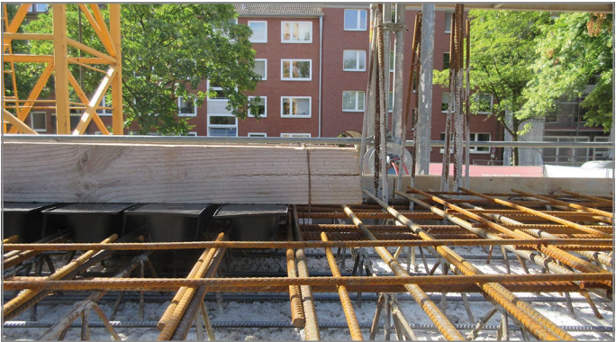
Afb. 32: Aanzicht vanaf de voorzijde: Houd het met stutbalken of steigerplanken op zijn plaats
