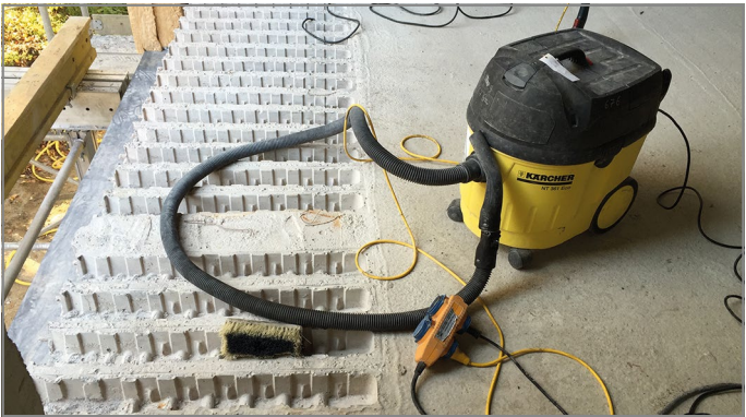
Afb. 50: Reinig de uitsparing met een industriële stofzuiger
