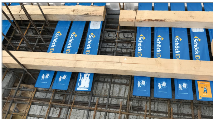
Afb. 26: Controleer of de bijlegwapening correct is geplaatst door er de vloerelementen op te leggen
