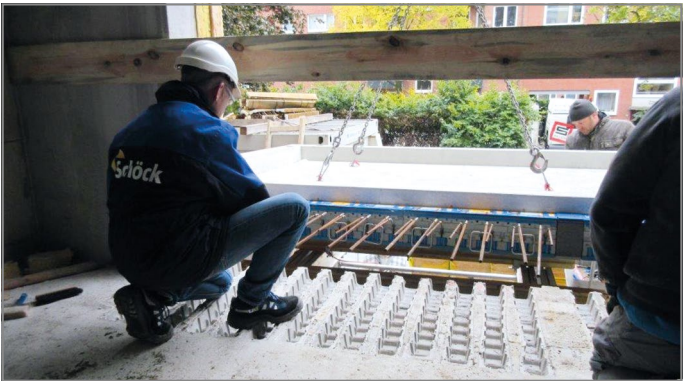
Afb. 59: Plaats prefabbalkons in de vloeruitparingen
