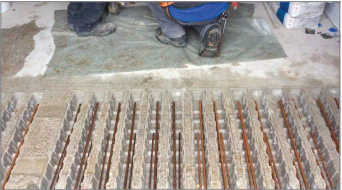
Afb. 64: Direct vóór het gieten van het beton
