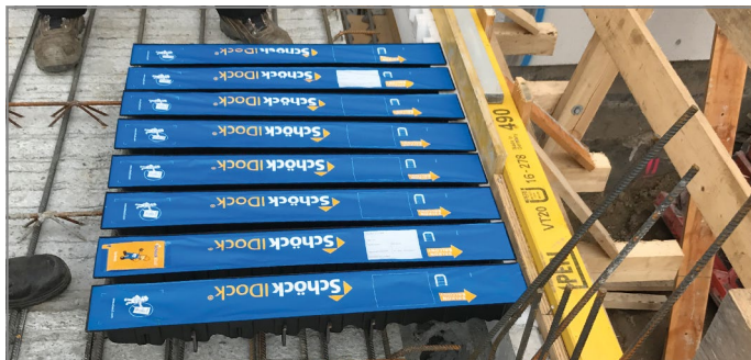
Afb. 29: Plaats de vloerelementen, trek de wapening in de verdieping van de uitsparingselementen omhoog en bevestig ze
