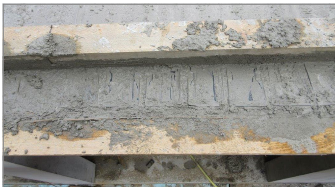
Afb. 38: Verwijder het overtollige beton
