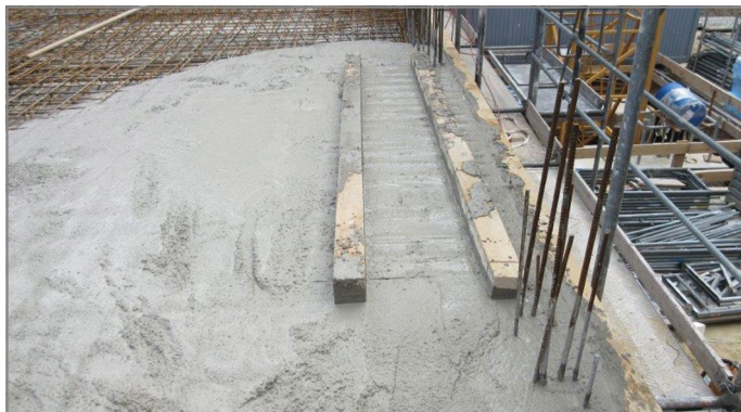
Afb. 37: Zorg dat het gegoten oppervlak geen gaten vertoont
