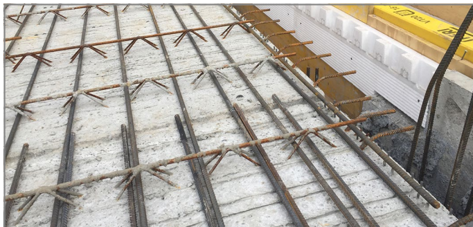
Afb. 41: Bevestig de randelementen op de ter plaatse gebouwde bekisting
