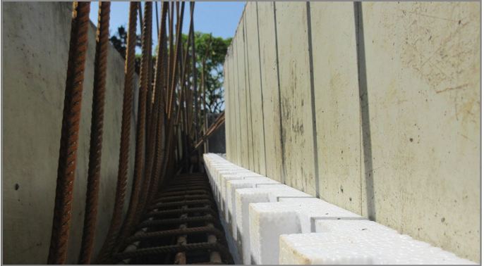
Afb. 43: Bevestig de randelementen op de bekisting van de buitenmuur
