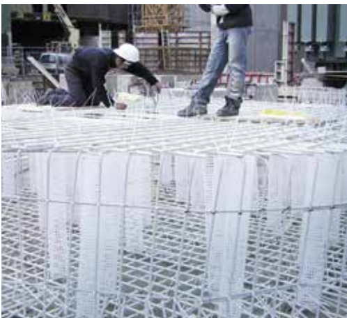
Fondations des transformateurs de la Peiner Träger GmbH à Peine en Allemagne.
