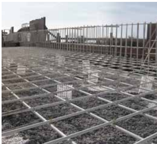
Renforcement des parapets et du tablier du pont du canal, au Canada.
