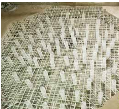
Fondation du système d'imagerie médicale et d'irradiation "MRIdian Linac" de l'Institut Paoli-Calmettes à Marseille en France.
