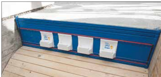
Ill. 97: Raccordement supérieur avec le Tronsole® type T
