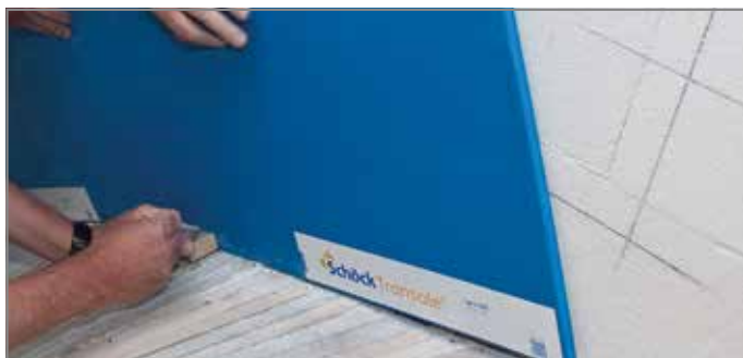
Ill. 126: Tracer le profil de marche inférieur du Tronsole® type L
