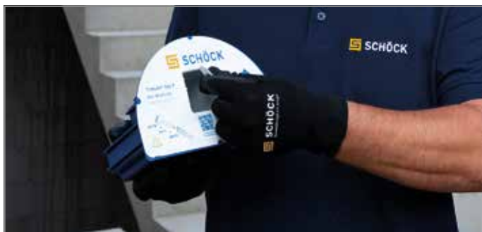
III. 42: Retirer le film adhésif de l'élément mural à l'endroit perforé
