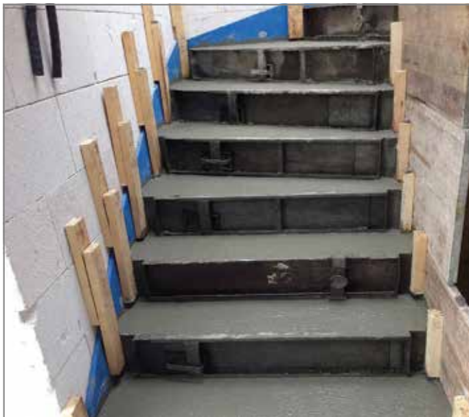
Ill. 133: Bétonner la volée d'escalier
