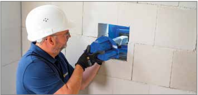
Ill. 45: Faire entrer l'élément porteur et l'élément mural dans la gaine de palier
