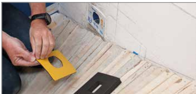
Ill. 62: En vertu des exigences de protection incendie R 90, retirer le film protecteur de l'élément de protection incendie
