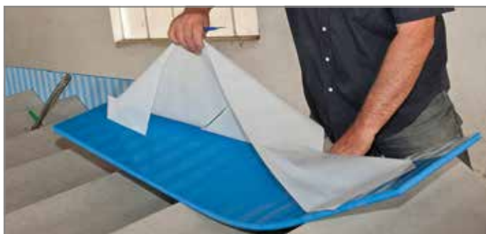
Ill. 139: Au niveau de la volée d'escalier, retirer le film de protection du Tronsole® type L
