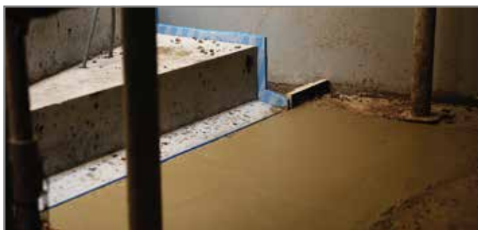
Ill. 100: Zone de raccordement bétonnée
