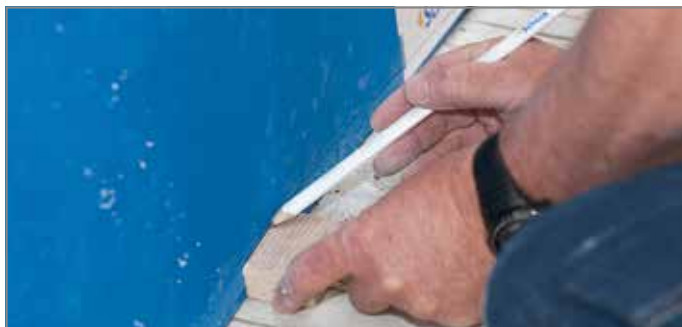
Ill. 127: Tracer le profil de marche inférieur du Tronsole® type L
