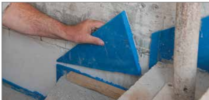
Ill. 134: Couper le Tronsole® type L avec un surplomb (d'env. 30 mm)
