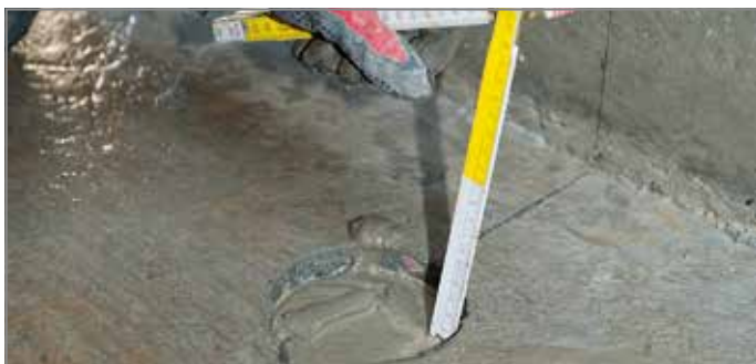
Ill. 121: Remplir le carottage avec du béton fluide jusqu'à 10 mm au-dessous du bord supérieur
