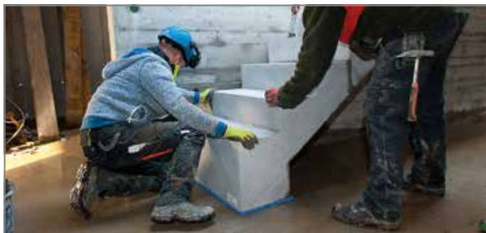
Ill. 123: Poser l'escalier
