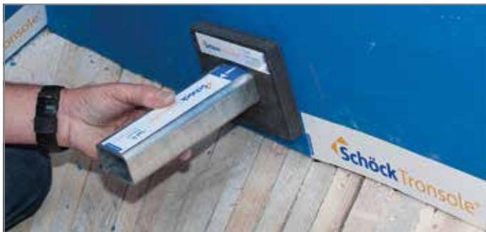
Ill. 64: Coller le Tronsole® type L (voir page 70), positionner la manchette de protection incendie et l'élément porteur
