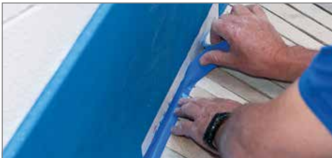
Ill. 70: Pour éviter les ponts acoustiques dus à la laitance du béton, les joints entre les éléments Tronsole® type Q et type L doivent être protégés et fermés à l'aide de la bande adhésive
