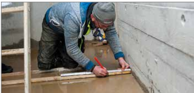
Ill. 115: Tracer la position du Tronsole® type D sur le radier
