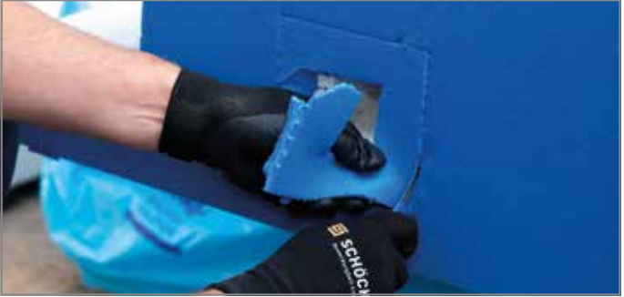
Ill. 38: Découper la forme de la gaine de palier
