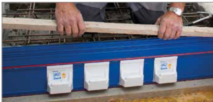
Ill. 93: Clipser la latte cloutée supérieure au Tronsole® type T
