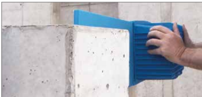
Ill. 53: Enfiler le Tronsole® type Z
