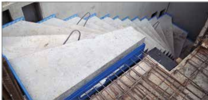
Ill. 102: Vérifier le joint de compression ( \geq 40 \text{ mm} ) entre le Tronsole® type T et la dalle/le palier
