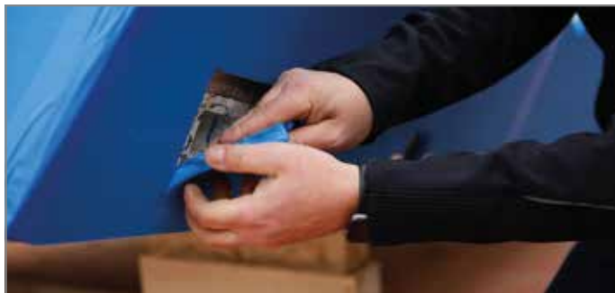
Ill. 77: Retirer le matériau préalablement découpé pour y insérer manchette de protection incendie
