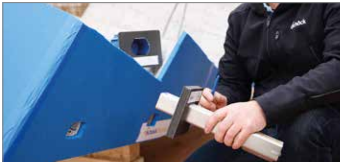
Ill. 75: Positionner l'élément porteur près de la gaine mobile
