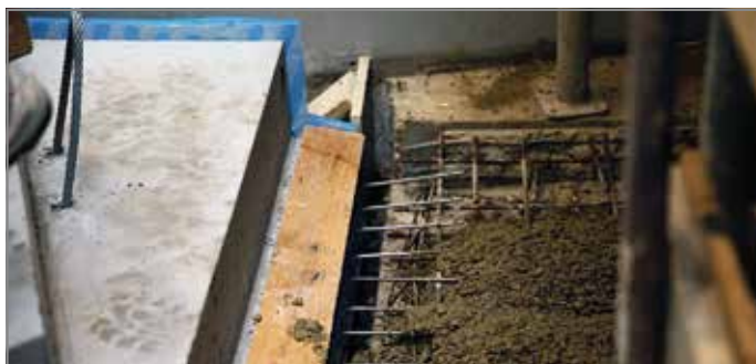
Ill. 99: Bétonner la zone de raccordement
