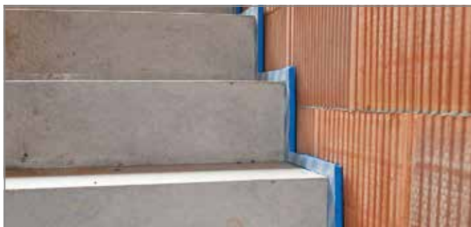
Ill. 147: Vérifier le surplomb du matériau de joint
