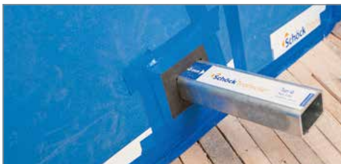
Ill. 69: Monter l'élément porteur et coller la manchette de protection incendie
