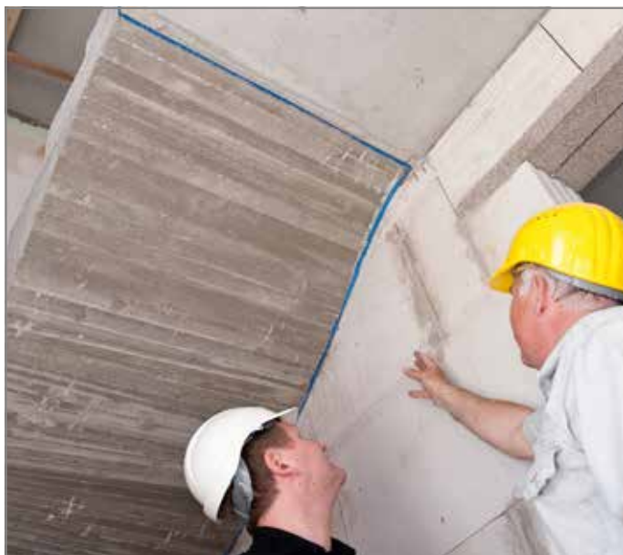
Ill. 135: La ligne bleue est un signe de qualité certifiant l'absence de ponts acoustiques et garant d'une protection acoustique optimale.
