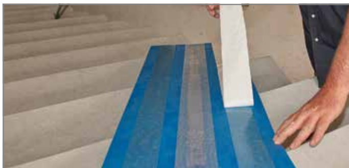
Ill. 111: Enlever le film protecteur de la bande adhésive du Tronsole® type B
