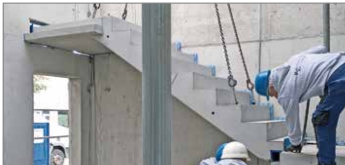
Ill. 56: Positionner la volée d'escalier
