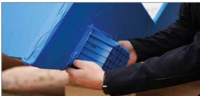
Ill. 82: Placer l'élément mural en position définitive et protéger les joints à l'aide de la bande adhésive
