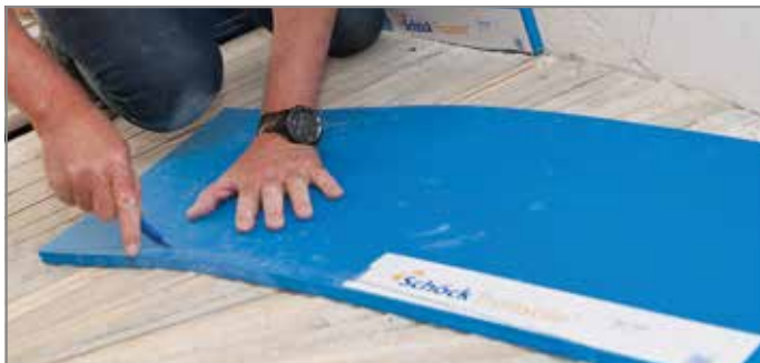
Ill. 128: Couper le profil de marche inférieur du Tronsole® type L
