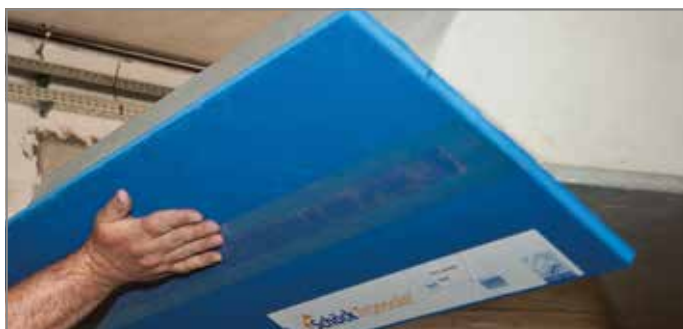
Ill. 112: Coller et presser le Tronsole® type B à la base de l'escalier de sorte que la position de la couche élastomère Elodur® soit au centre de la cage d'escalier
