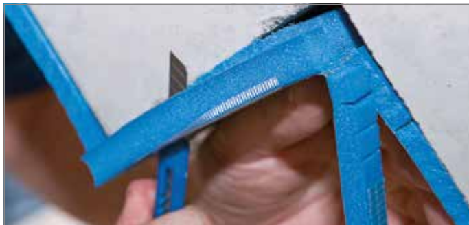
Ill. 108: Couper le Tronsole® type BZ à fleur de l'escalier
