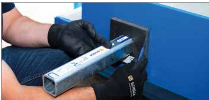
Ill. 37: Positionner la manchette de protection incendie et l'élément porteur, marquer le contour géométrique de la manchette de protection incendie sur le matériau de joint type L
