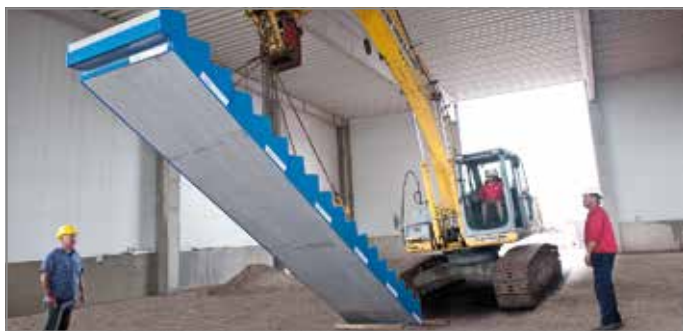
Ill. 145: Poser l'escalier préparé
