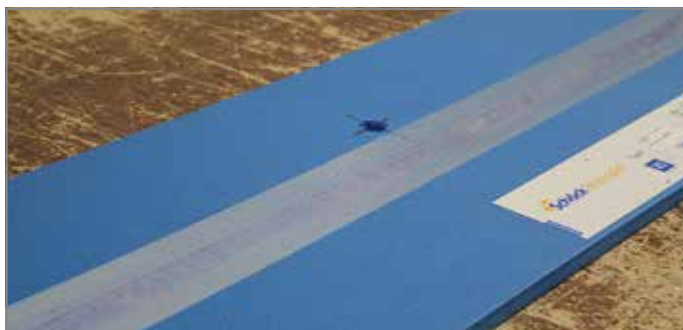
Ill. 118: Tracer la position du Tronsole® type D et la découper
