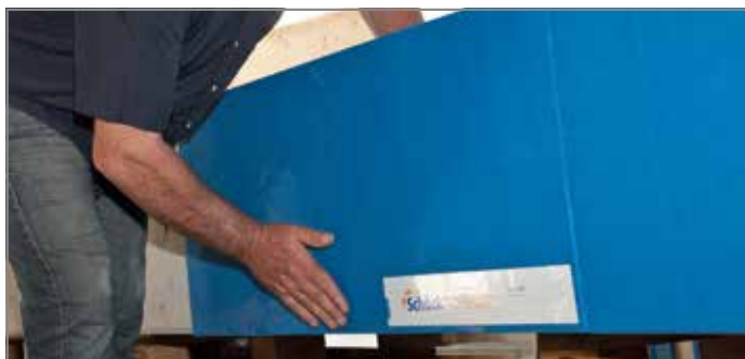
Ill. 141: Appuyer sur le Tronsole® type L
