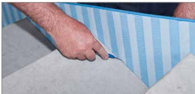
Ill. 138: Couper le film protecteur au niveau de la surface à coller
