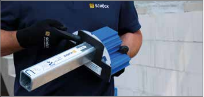
Ill. 44: Faire entrer l'élément porteur jusqu'à la butée dans l'élément mural
