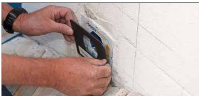
Ill. 63: Coller le matériau de protection incendie
