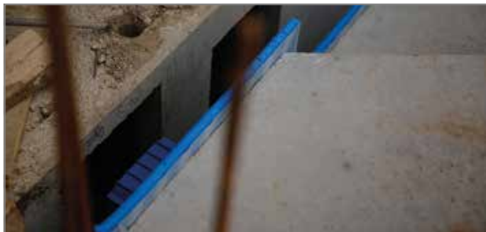
Ill. 83: Introduire l'escalier avec le Tronsole® type Q dans les ouvertures
