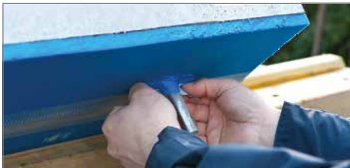
Ill. 120: Fermer les joints entre les Tronsole® type D et type B pour que la laitance du béton ne s'y infiltre pas
