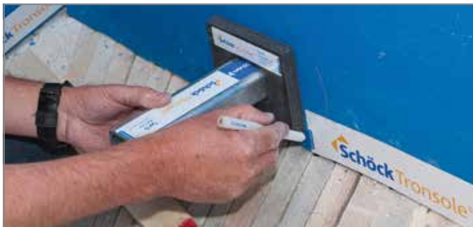
Ill. 65: Marquer la manchette de protection incendie sur le matériau de joint type L
