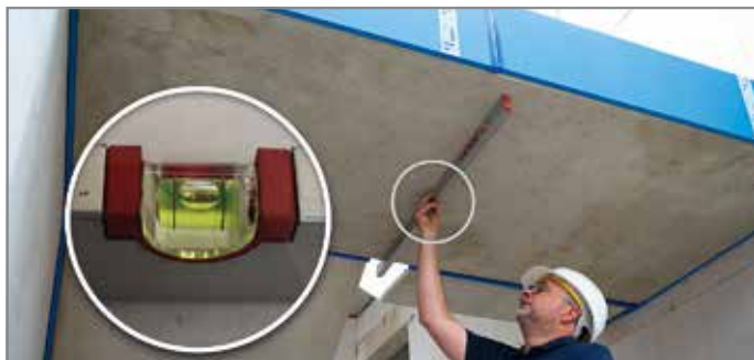
Ill. 50: Vérifier que le palier soit bien posé à l'horizontale après avoir placé la volée d'escalier
