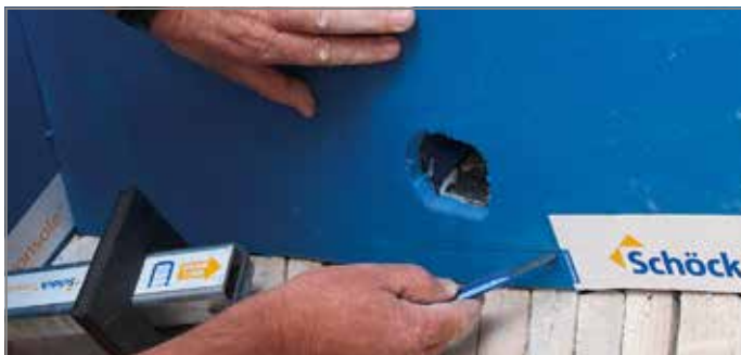
Ill. 66: Découper la forme de la manchette de protection incendie
