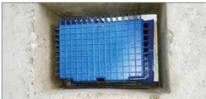
Ill. 57: Procéder au réglage en hauteur du Tronsole® type Z avec des cales résistantes à la compression
