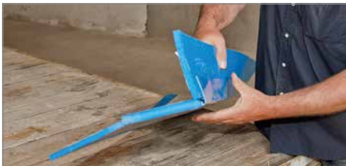
Ill. 105: Clipser la charnière du Tronsole® type BZ à un angle de 90°
