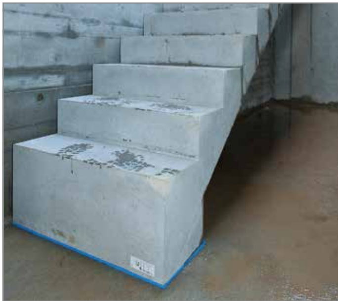
Ill. 124: La volée d'escalier est posée sur les Tronsole® type B et type D de manière insonorisée. Le joint entre la volée d'escalier et le mur de la cage d'escalier est conçu ici comme un joint ouvert large
