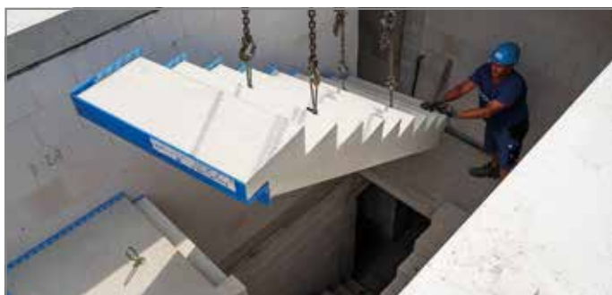
Ill. 49: Installer la volée d'escalier
