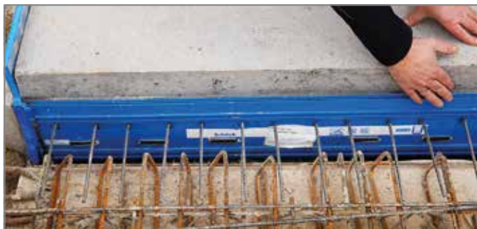
Ill. 98: Positionner et soutenir l'escalier
