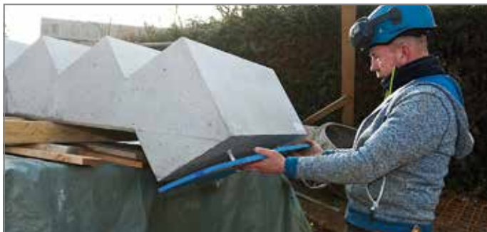
Ill. 119: Enlever les poussières de l'escalier et installer le Tronsole® type B
