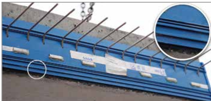
Ill. 103: Retirer impérativement la latte cloutée
