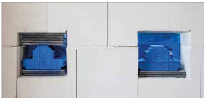
Ill. 47: Masquer l'élément mural. En cas d'efforts de soulèvement, placer des cales résistantes à la compression, aussi bien en haut qu'en bas
