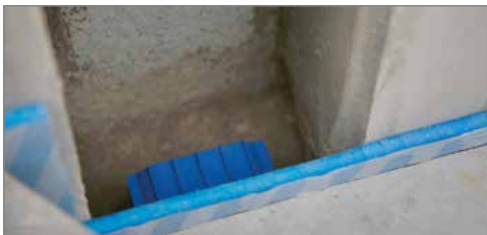
Ill. 87: Bétonner les ouvertures
