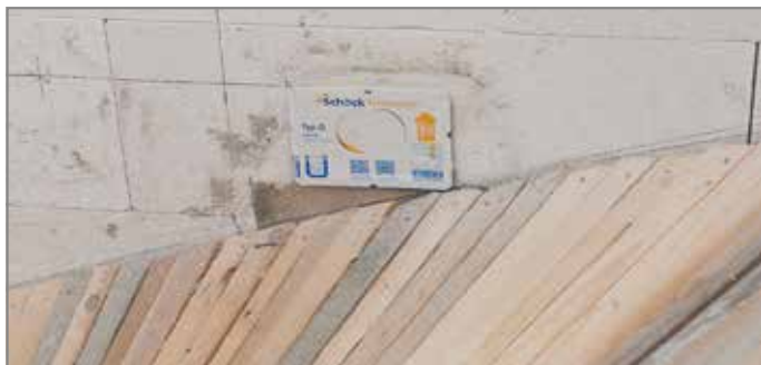
Ill. 61: Élément mural Tronsole® type Q encastré dans un mur en maçonnerie
