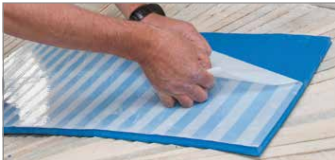
Ill. 130: Retirer à moitié le film de protection du Tronsole® type L ou retirer env. 150 mm
