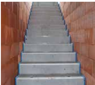
Ill. 6: La ligne bleue est un signe de qualité certifiant l'absence de ponts acoustiques et garant d'une protection acoustique optimale.
