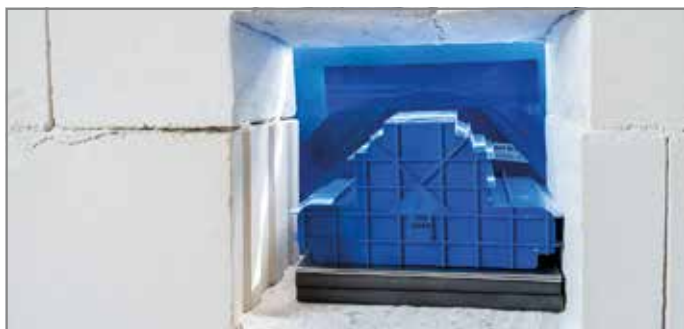
Ill. 51: Bétonner l'ouverture
