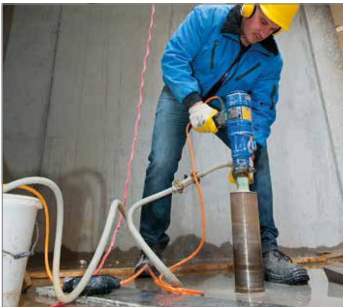
Ill. 116: Réaliser le carottage avec un diamètre de 100 mm dans le radier
