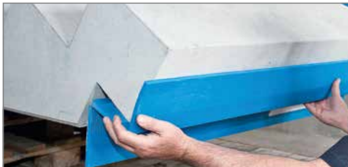
Ill. 107: Coller le côté supérieur du Tronsole® type BZ
