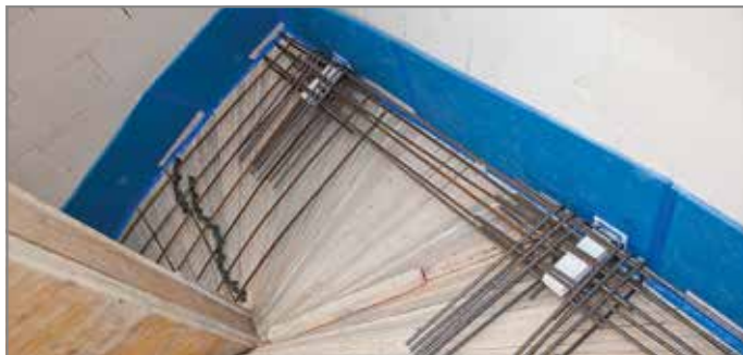
Ill. 73: Pose de l'armature
