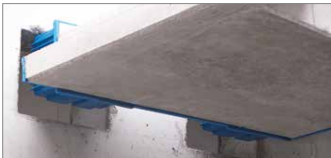
Ill. 55: Introduire l'escalier avec le Tronsole® type Z dans les ouvertures
