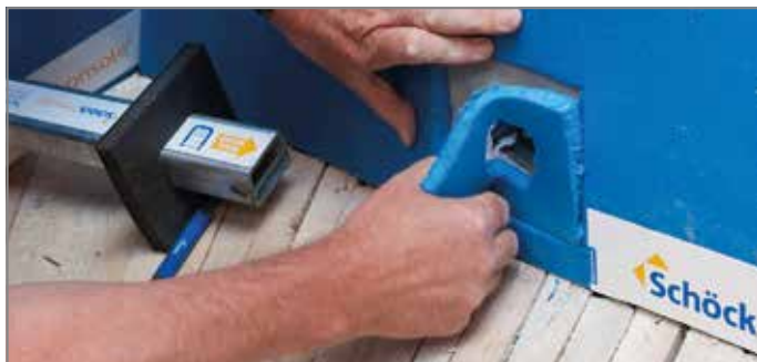
Ill. 67: Retirer le matériau préalablement découpé pour y insérer manchette de protection incendie
