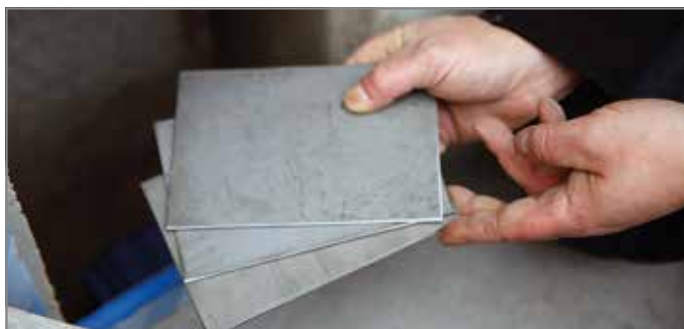
Ill. 85: Procéder au réglage en hauteur du Tronsole® type Q avec des cales résistantes à la compression
