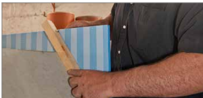
Ill. 142: Couper le Schöck Tronsole® type L avec un surplomb (d'env. 30 mm)
