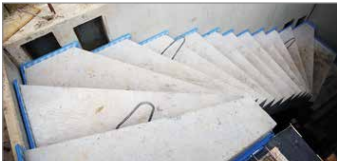
Ill. 86: La ligne bleue est un signe de qualité d'installation certifiant l'absence de ponts acoustiques et garantissant une protection acoustique sûre
