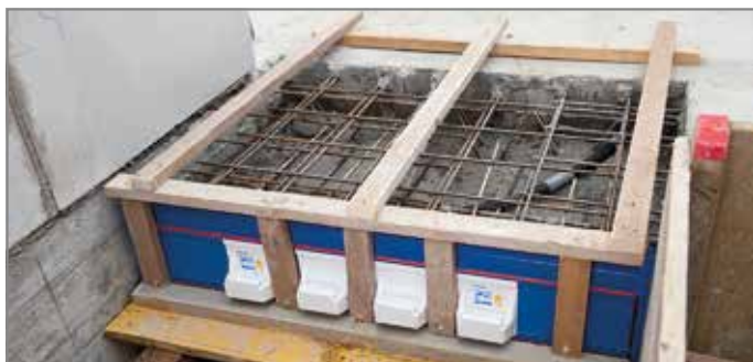
Ill. 95: Avant le bétonnage
