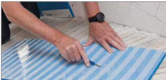
Ill. 129: Inciser le film de protection à env. 150 mm du bord inférieur et le retirer
