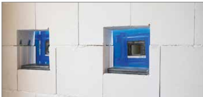
III. 41: Positionner le palier à la hauteur des évidements muraux
