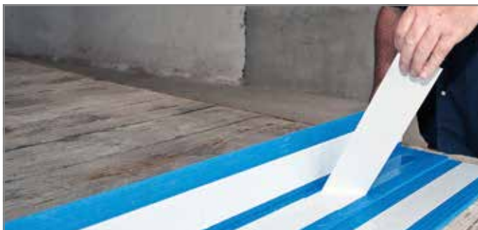
Ill. 106: Enlever le film protecteur de la bande adhésive du Tronsole® type BZ
