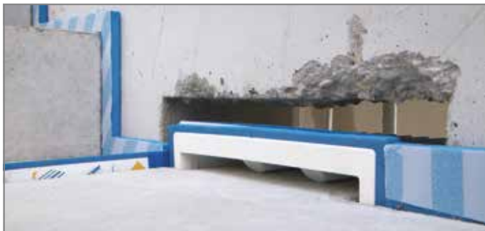
Ill. 59: Bétonner l'ouverture
