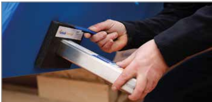
Ill. 76: Découper la forme de la manchette de protection incendie
