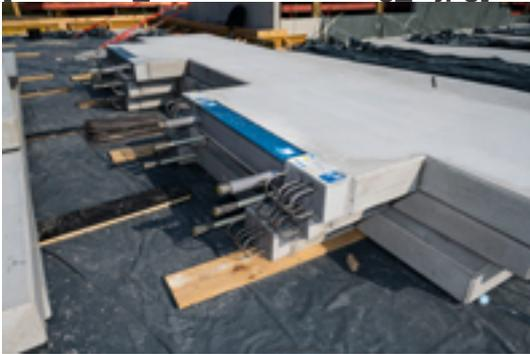
*Die Fertigteile für die Brüstungen mit dem eingebauten Schöck Isokorb. Foto: Schöck Bauteile GmbH*
