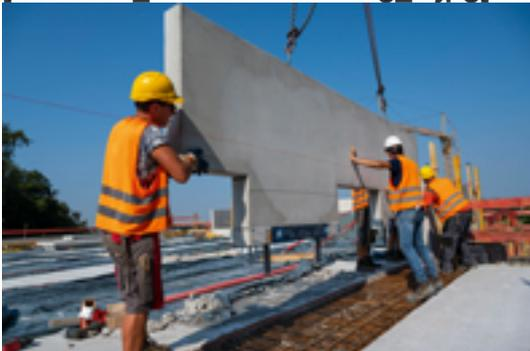
*Der Schöck Isokorb stellt die statische Funktion der Fertigteilbrüstungen sicher und trennt sie zugleich dauerhaft und effizient thermisch vom Umkehrdach und den sensiblen Räumen unterhalb. Foto: Schöck Bauteile GmbH*
