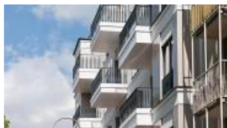
Remont balkonów w wykorzystaniem łącznika Isokorb R
