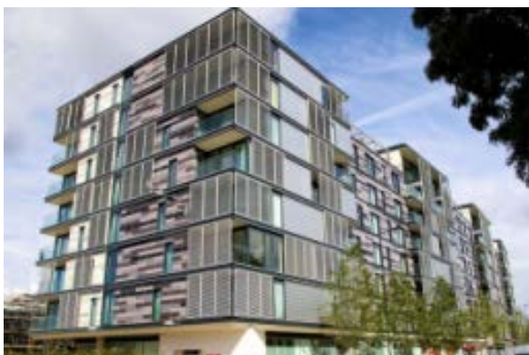
Isokorb® è un giunto isolante utilizzato per il taglio termico dei balconi e degli altri elementi a sbalzo delle facciate (Foto Schöck Italia)
