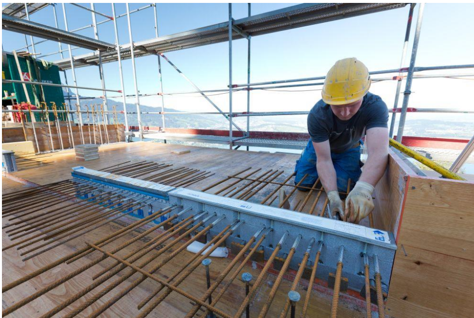
[schoeck buergenstock4] Die gut 100 auf dem Bürgenstock verbauten Schöck Isokorb Elemente sind allesamt Standardanfertigungen und somit auch wirtschaftlich interessant. Foto: Patrick Lüthy/Imagopress.
