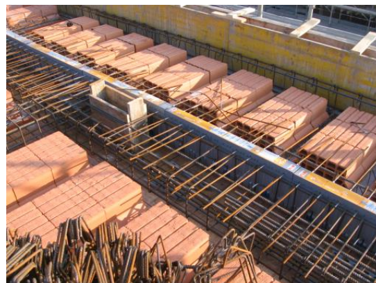
Foto 7: posa in opera dei giunti Isokorb® di Schöck
