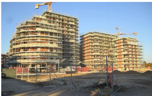
Foto 6: avanzamento dei lavori. Termine previsto a fine 2016
