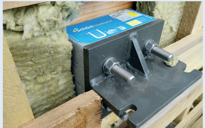
Mise en œuvre du rupteur Schöck Isokorb® KST pour assurer l'isolation thermique et le transfert des sollicitations structurelles de cette construction métallique.
