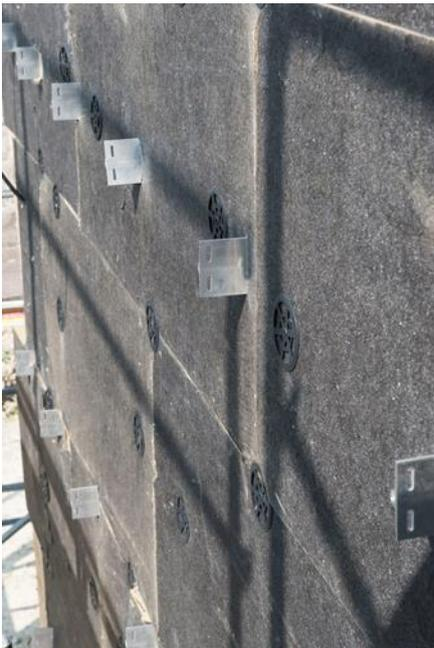
*Auf die vorbereitete Außenwand des Gebäudes wird der Fluegeladapter montiert. Anschließend erfolgt darauf die Befestigung des Profils sowie der Fassadenbekleidung. Foto: Schöck Bauteile GmbH*
