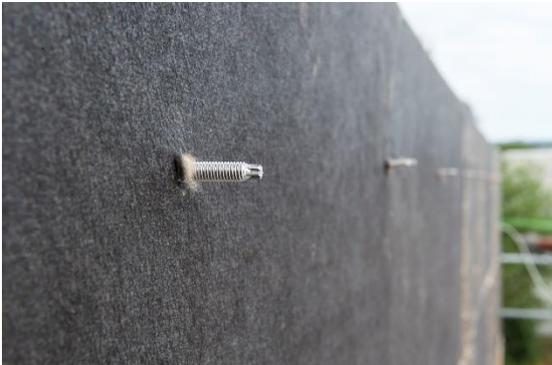
*Die mineralische Wärmedämmung kann ohne Vorstechen einfach und schnell montiert werden. Foto: Schöck Bauteile GmbH*
