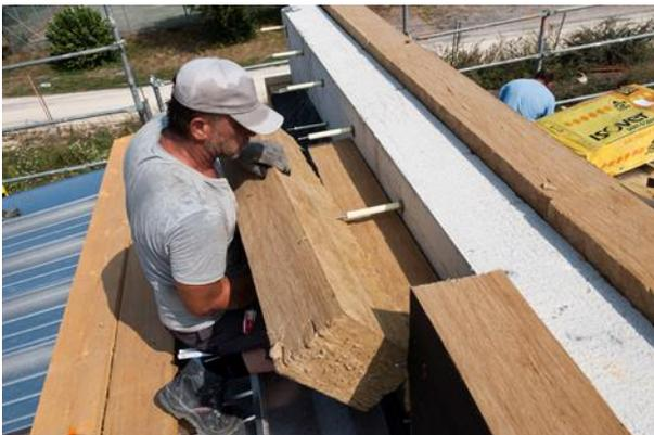
*Der Isolink Typ TA-S ermöglicht eine rechnerisch wärmebrückenfreie Konstruktion. Dadurch lassen sich 50 Prozent des Dämmmaterials einsparen. Foto: Schöck Bauteile GmbH*
