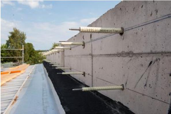
*Der Isolink Typ TA-S kommt mit einer Verankerungstiefe von nur 40 mm aus. Eine Beschädigung der Betonbewehrung beim Setzen der Bohrlöcher ist dadurch nahezu ausgeschlossen. Foto: Schöck Bauteile GmbH*
