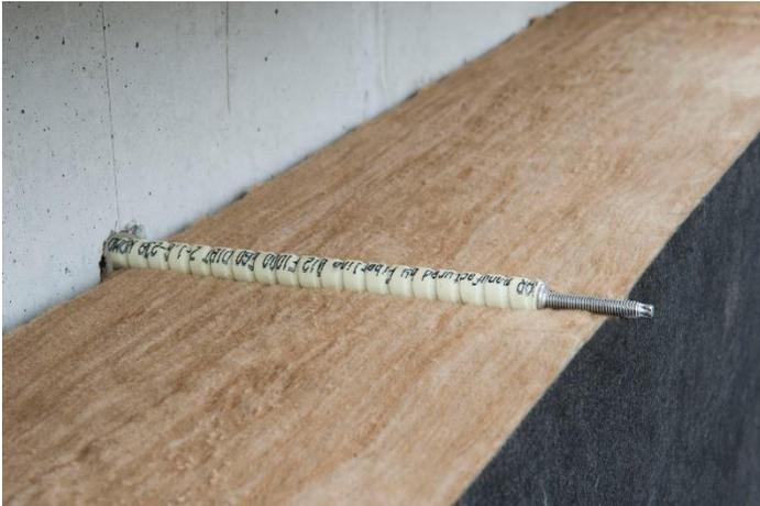
*Der Fassadenanker Isolink Typ TA-S besteht aus dem Glasfaserverbundwerkstoff Combar und einem Anschlussgewinde aus Edelstahl. Foto: Schöck Bauteile GmbH*
