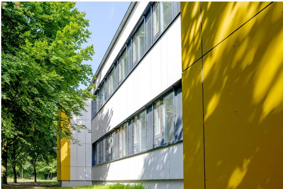
*Die Elisabeth-Siegel-Schule in Osnabrück: Das Bestandsgebäude wurde im Zuge von Modernisierungsmaßnahmen mit der Unterkonstruktion VECO-Isolink energetisch und optisch aufgewertet. Foto: Schöck Bauteile GmbH*
