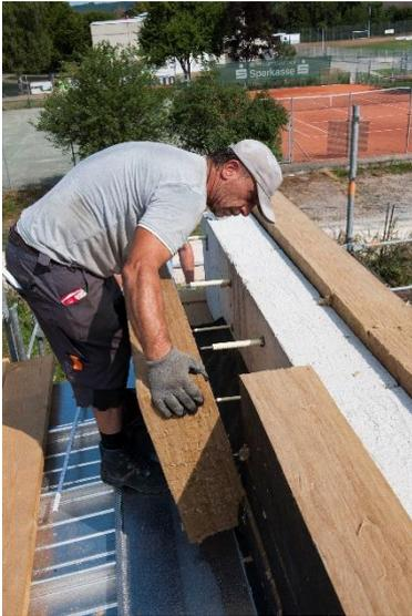
*Die Dämmung kann schnell und einfach auf die Anker gesetzt werden, weil der Isolink Typ TA-S die Platten leicht durchstößt und ein Setzwerkzeug überflüssig ist. Foto: Schöck Bauteile GmbH*
