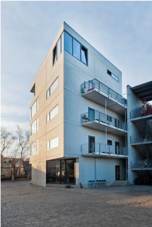
*Die Beton-Fertigteilelemente des Anbaus sind zugleich tragende als auch formgebende Elemente. Foto: Schöck Bauteile GmbH, Abdruck honorarfrei.*
