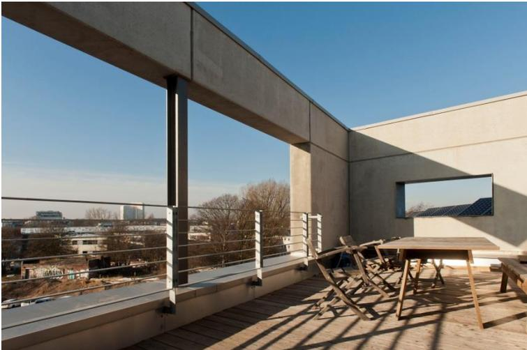
*Innen- und Außenschale der Sichtbetonwände sind mit dem Schöck Thermoanker verbunden. Foto: Schöck Bauteile GmbH, Abdruck honorarfrei.*
