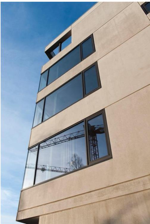
*Jeweils zwei vorgefertigte, geschosshohe Fertigteilplatten umschließen Styropordämmung und Ortbetonbereich der Sichtbetonwände. Foto: Schöck Bauteile GmbH, Abdruck honorarfrei.*
