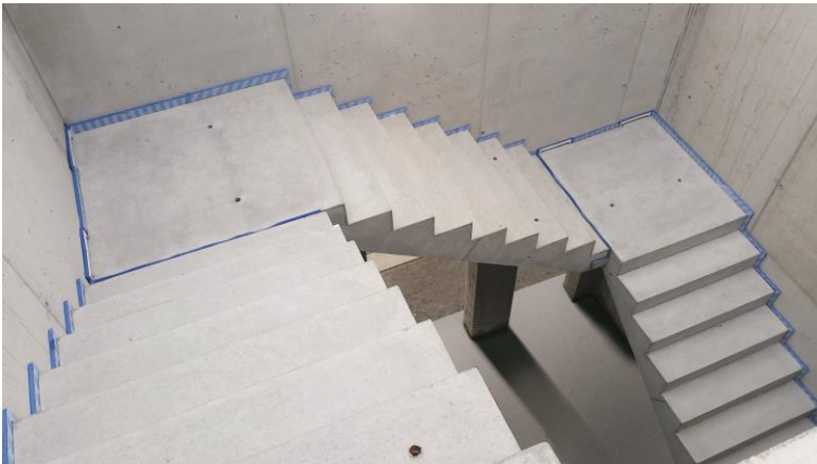
Alle Schöck Tronsole Typen sind nach DIN 7396 geprüft. Im System ergeben sie eine blaue Linie, welche für einen Schallschutz auf hohem Niveau steht. Foto: Schöck Bauteile GmbH, Abdruck honorarfrei.
