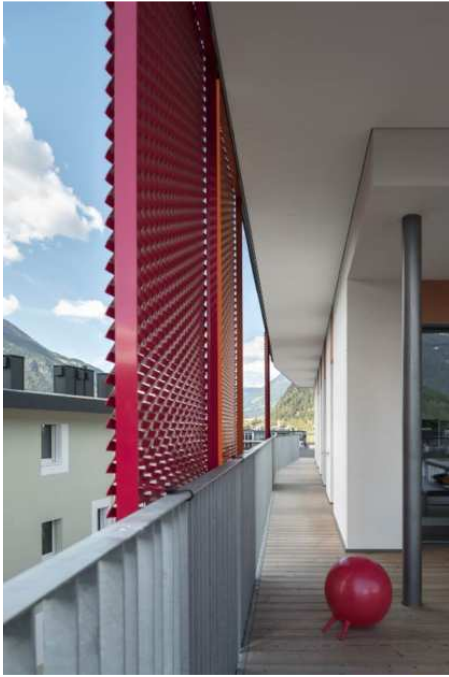
Foto 4 + 5: Il progetto DeCo prevede ca. 40 m 2 di balconi di pertinenza esclusiva per ogni appartamento con sporgenze variabili da 70 a 150 cm. Per evitare la comparsa di ponti termici in corrispondenza dei balconi sono stati utilizzati i giunti termici Isokorb® di Schöck ©Oliver Jaist
