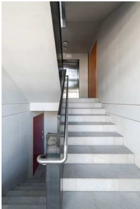
Foto 6: Nel progetto DeCo è stato utilizzato il sistema di isolamento anticalpestio Schöck Tronsole® che permette di contenere il livello del rumore da calpestio nel vano scale. ©Oliver Jaist
