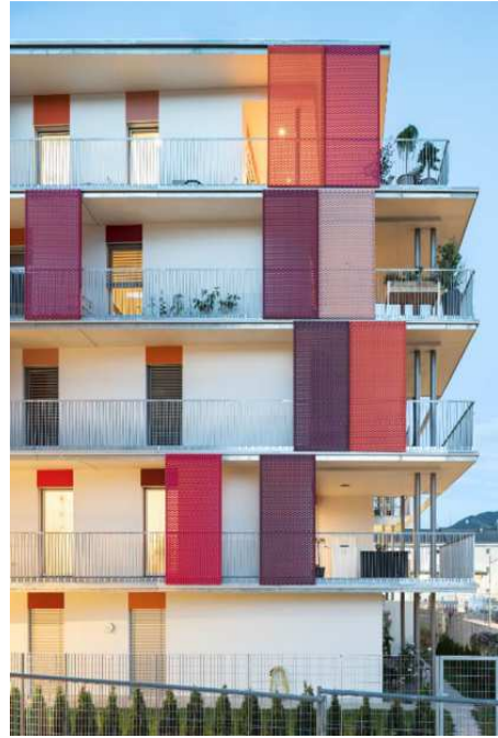
Foto 4 + 5: Il progetto DeCo prevede ca. 40 m 2 di balconi di pertinenza esclusiva per ogni appartamento con sporgenze variabili da 70 a 150 cm. Per evitare la comparsa di ponti termici in corrispondenza dei balconi sono stati utilizzati i giunti termici Isokorb® di Schöck ©Oliver Jaist
