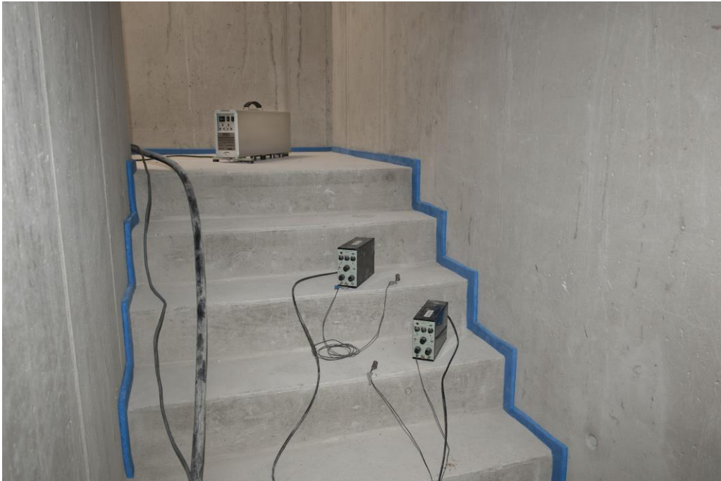
Schoeck_Messung_Trittschallmessgeraet.jpg: Trittschallmessgerät auf dem schallgedämmten Treppenlauf
