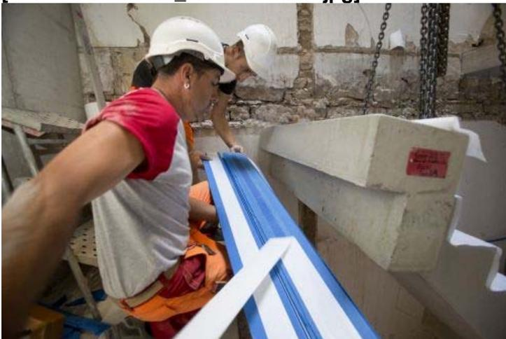
*Die selbstklebende Schöck Tronsole wird in wenigen Minuten am oberen und unteren Auflageende des Treppenelementes angebracht. Je nach Bauablauf kann das Anbringen des Dämmstreifens ohne weiteres auch im Fertigteilwerk vorgenommen werden.*
