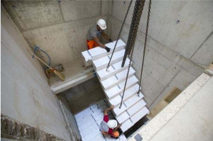
*Die vorgefertigten Treppenelemente wurden per Kran in das neu betonierete Treppenhaus eingebracht und passgenau versetzt.*
