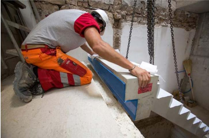
*Das vorgefertigte Treppenelement wird ohne zusätzliches Betonieren oder Kleben an der entsprechenden Stelle aufgelegt. Die Tronsole von Schöck dient nun als Schallbarriere zwischen den zwei Bauteilen.*
