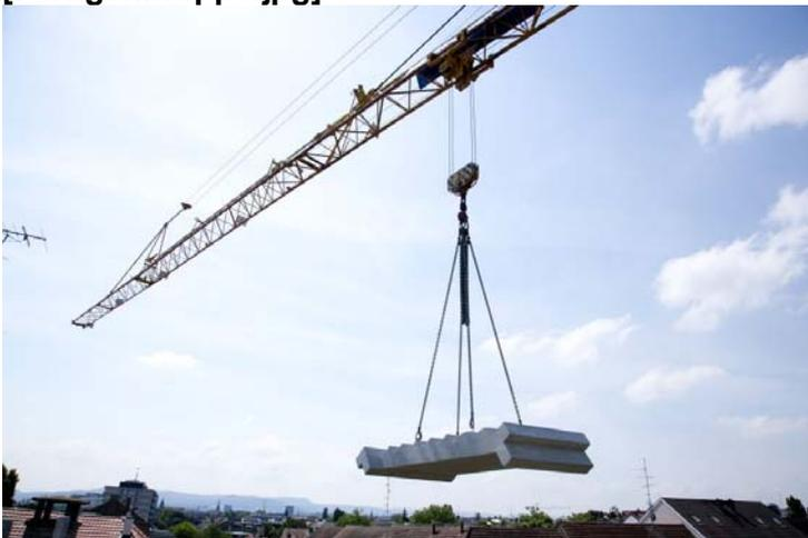
*Die 10 jeweils zwei Tonnen schweren Treppenelemente wurden im Werk vorgefertigt, angeliefert und per Kran zum Bestimmungsort gebracht.*
