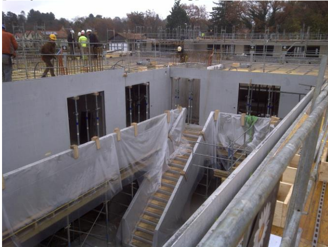
[chapelle rohbau innenhof.jpg]
