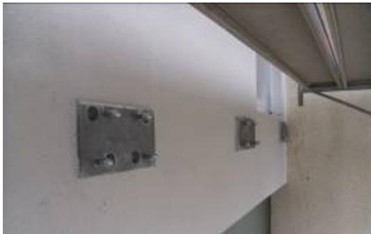
*Sonderlösung: Um die Dämmstärkendifferenz zwischen Isokorb R und Wärmedämmverbundsystem zu überbrücken, wurden am Objekt in der Breitscheidstraße spezielle Distanzplatten angebracht.*
