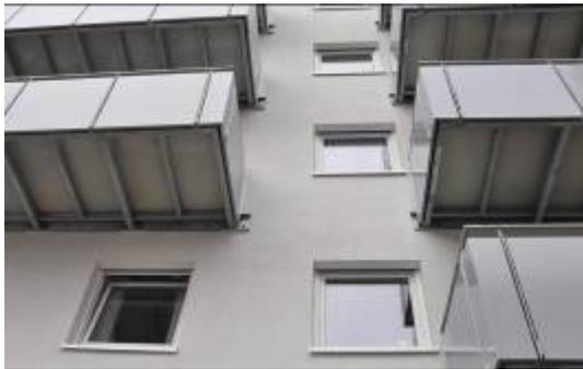
*Unsichtbare Technik: Der Isokorb R ermöglichte einen optisch ansprechenden, technisch sauberen und hoch energieeffizienten Anschluss der Stahlbalkone an den Altbau.*
