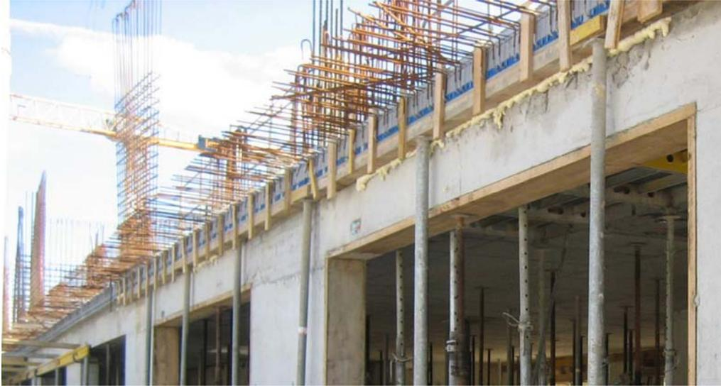
*Mit massgeschneiderten Isokorb-Typen werden Wärmebrücken beim Genfer Bauprojekt effektiv reduziert. Sie sorgen zudem um einen bis zu 50 Prozent verbesserten Trittschallschutz.*
