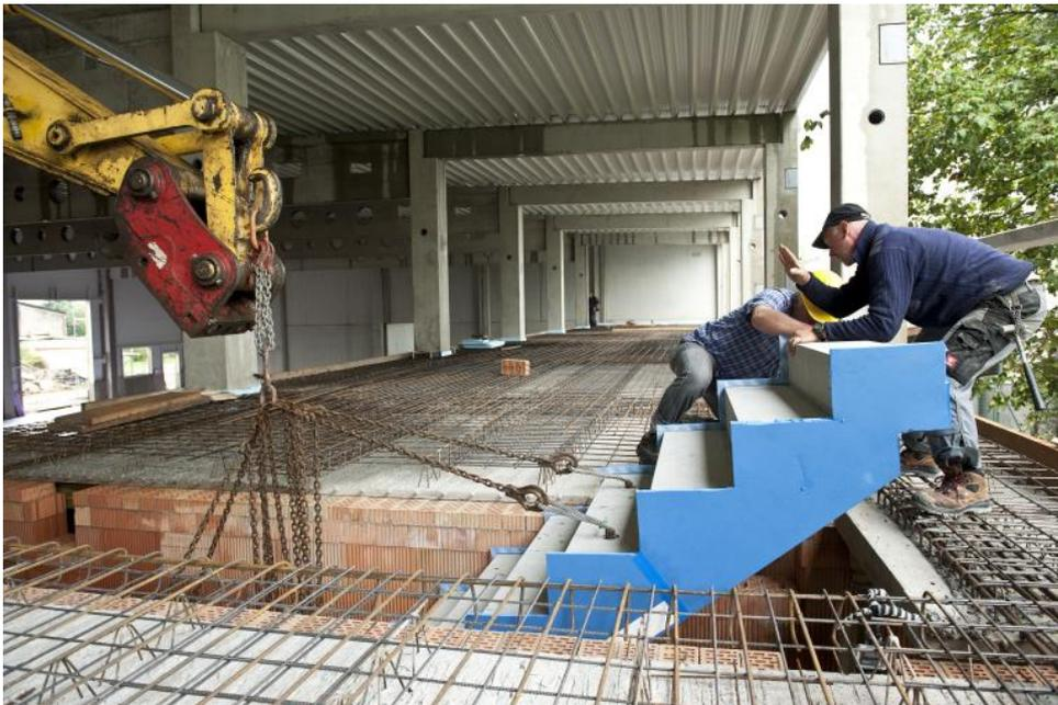
Foto 4 – Posa di scale prefabbricate in cui è visibile Tronsole®, soluzione innovativa per la perfetta insonorizzazione del vano scale
