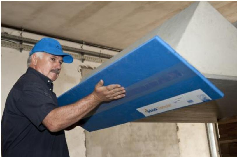
Foto 3 – Applicazione di Tronsole® Tipo B su scala prefabbricata per il raccordo della rampa al pianerottolo.
