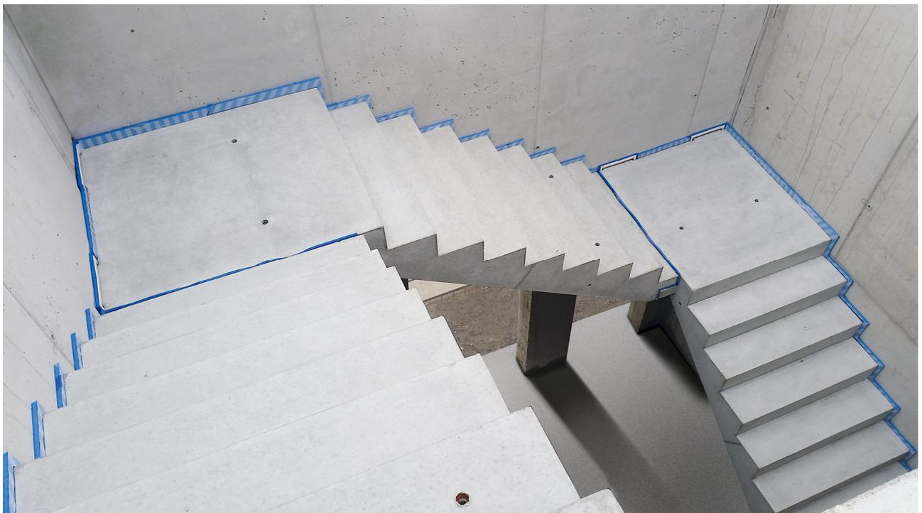
*Gerade Treppe mit Trittschalldämmung an den Anschlüssen und in der Fuge mit Schöck Tronsole. Foto: Schöck Bauteile AG, Abdruck honorarfrei.*
