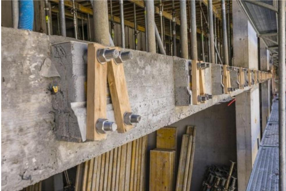
*Mit dem Schöck Isokorb konnten die Vordächer am Erweiterungsbau trotz der Schneelasten von bis zu 550 kg/m<sup>2</sup> mit einer freien Auskragung von 2.80 m realisiert werden.*
