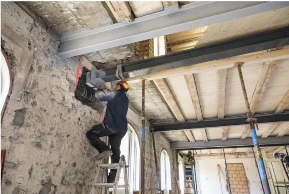
*Für den umfangreichen Innenausbau war eine Lastenerhöhung notwendig. Dazu wurden zusätzliche Stahlträger eingezogen und mit Schöck Dämmelementen in der Aussenwand verankert.*
