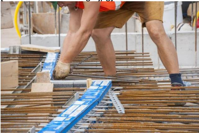
*Diese Kragplatten wurden mit Schöck Isokorb Elementen thermisch von der Deckenplatte abgekoppelt, wobei deren 12-cm-Dämmung bei der Zertifizierung nach Minergie-P-Eco<sup>®</sup> zusätzliche Punkte einbrachte.*
