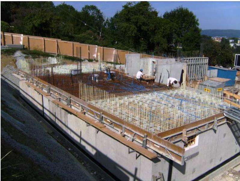
*Bewehrung mit besonderen Eigenschaften: Die Glasfaserbewehrung Schöck ComBAR ist nicht magnetisierbar, leitet keine elektrischen Ströme, ist korrosionsresistent und wesentlich leichter als Betonstahl.*
